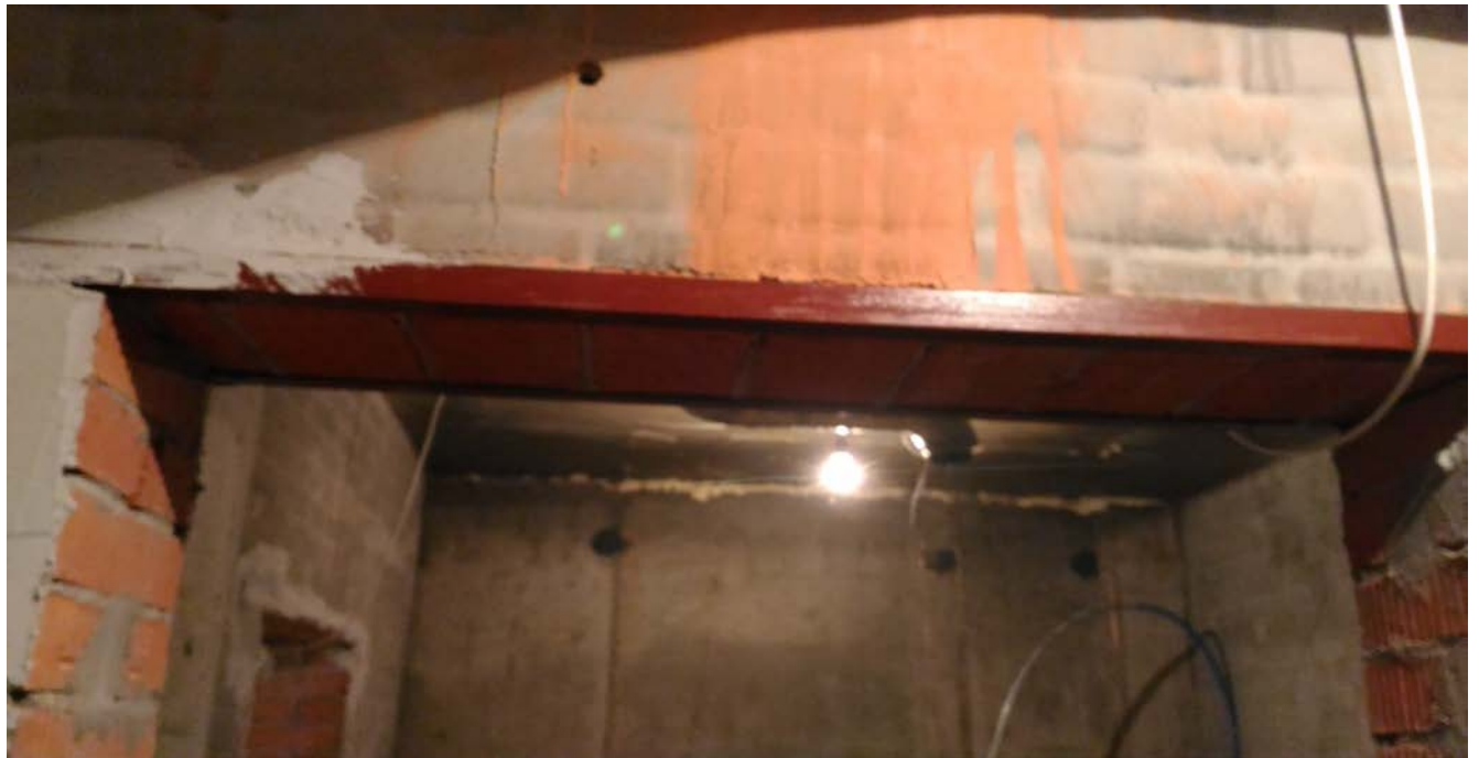
Установка перемычек дверных проемов.
