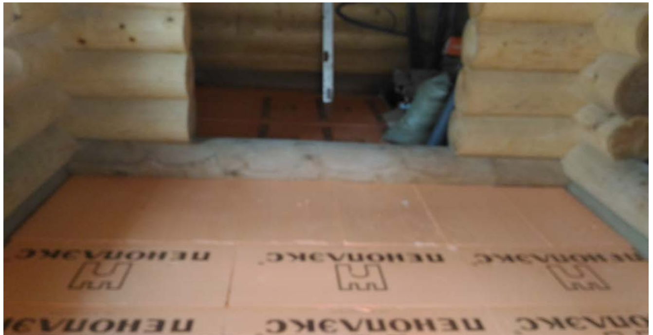
Ут епление перекрыт ия цокольного эт ажа
