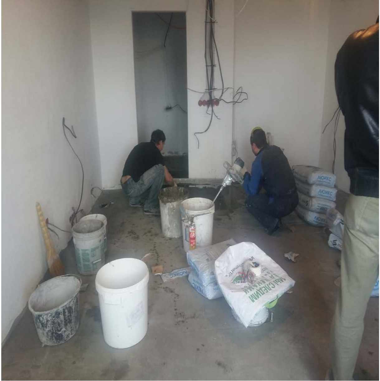
Фото2. Устройство цементно-песчаной стяжки
