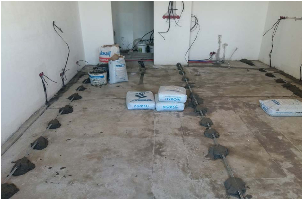
Фото1. Монтаж маяков. Монтаж электропроводки
