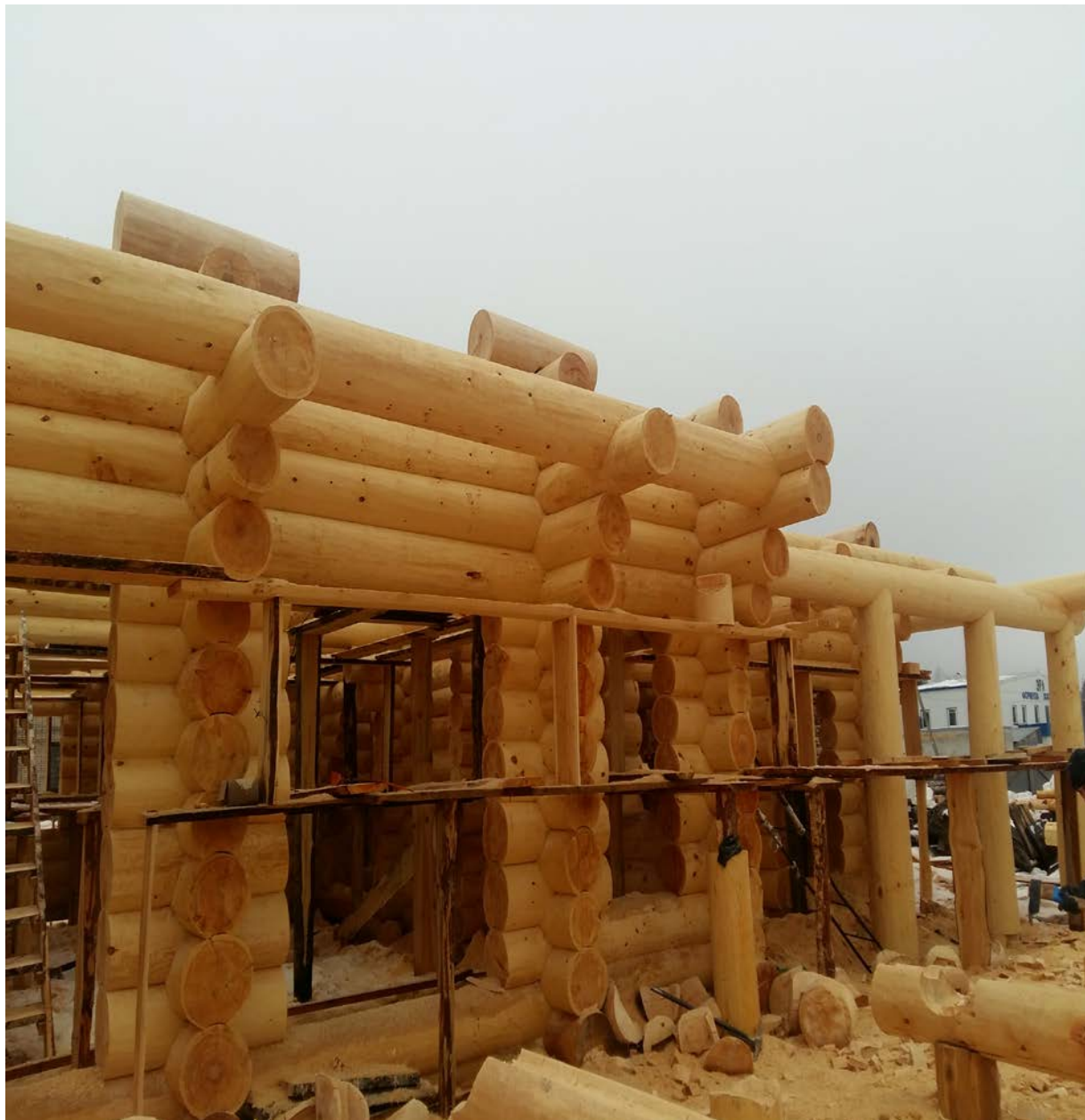
Фото1. Монтаж стен второго этажа
