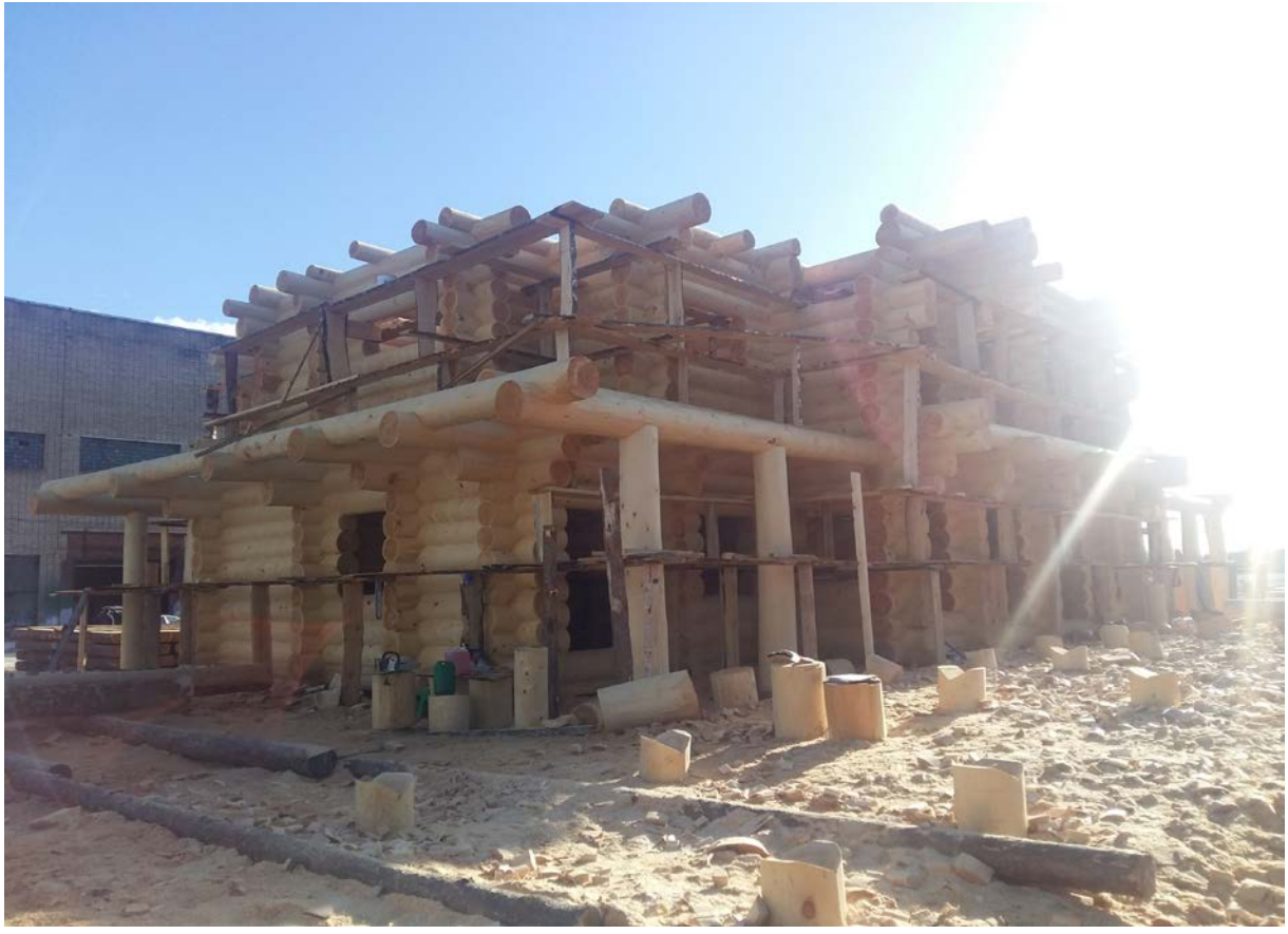
Фото 4. Завершение монтажа основных стен
