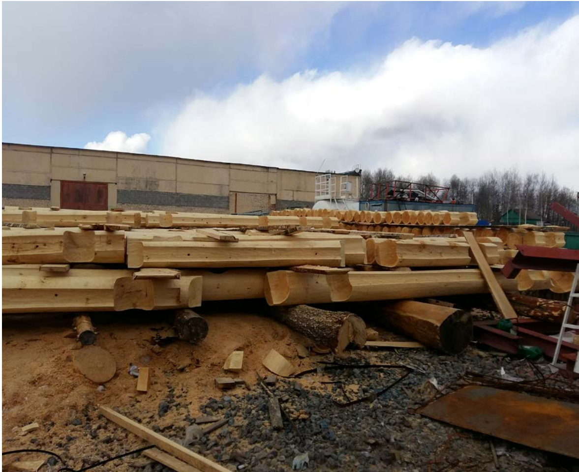
Фото 6. Разборка смонтированного дома перед отправкой на участок
