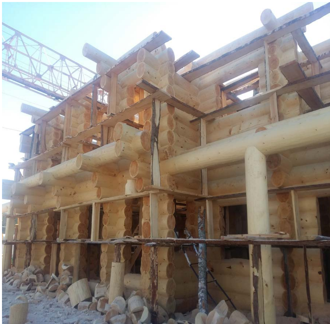
Фото2. Монтаж стен второго этажа
