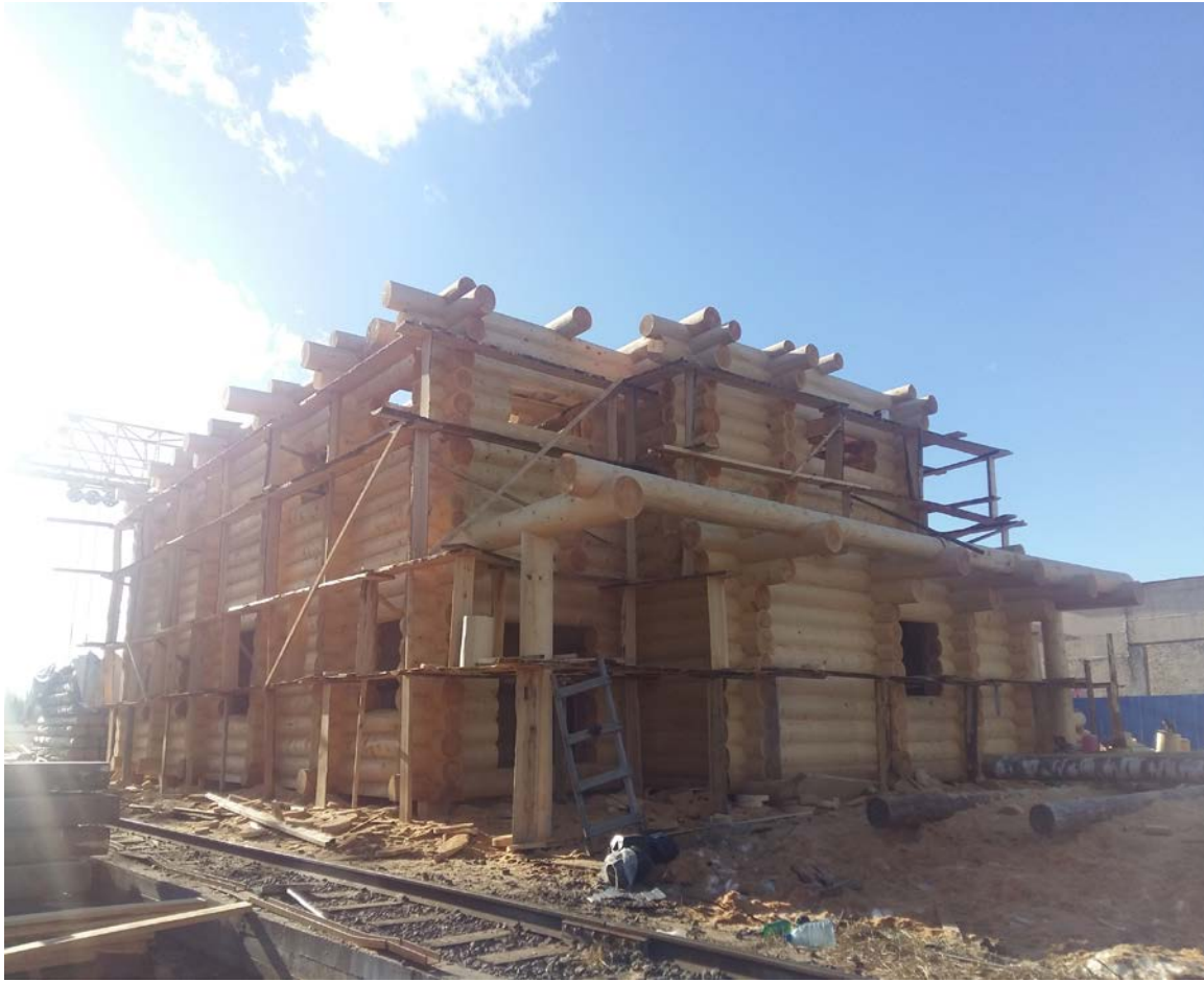
Фото 3. Завершение монтажа основных стен
