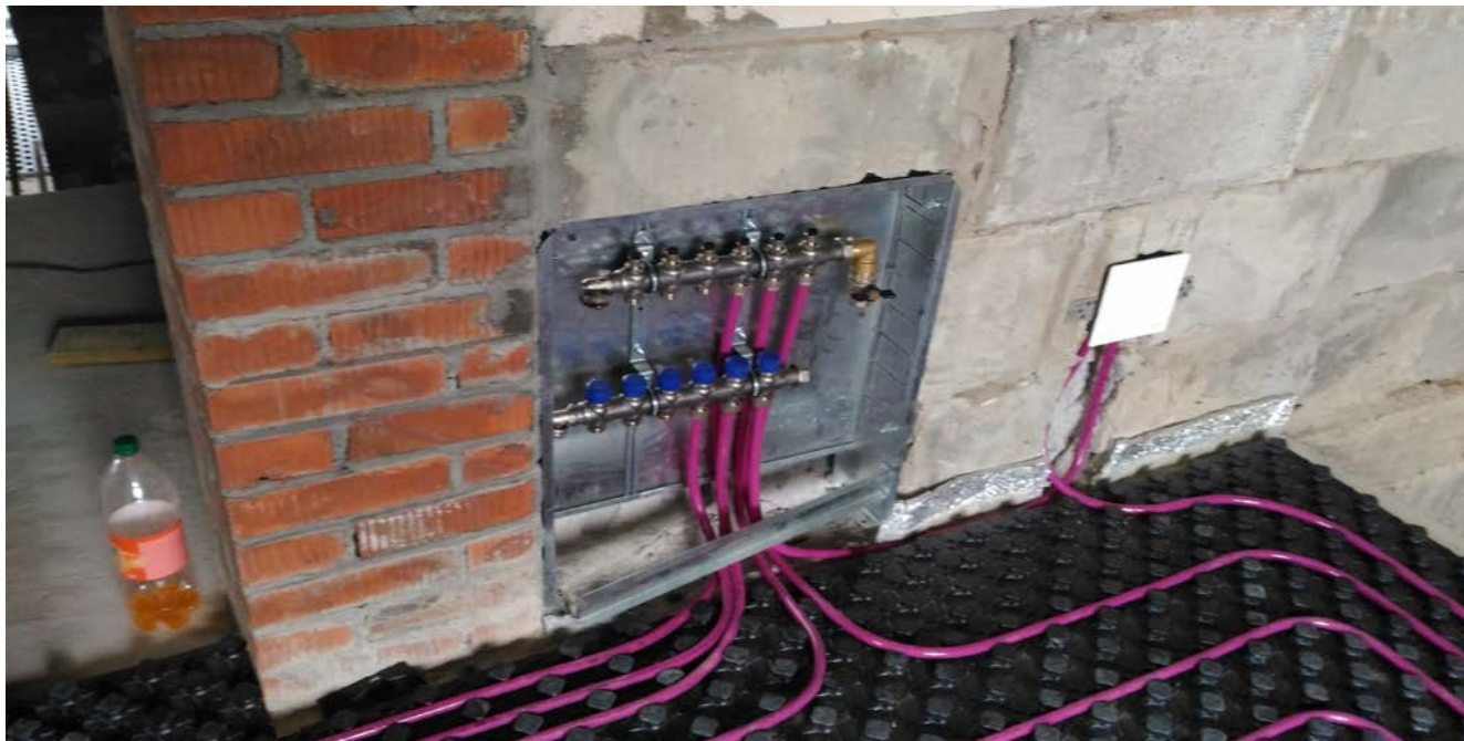
Монтаж запорно-регулирующей арматуры.
