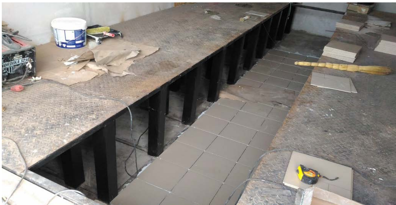
Окончание работ по устройству эстакады в гараже
