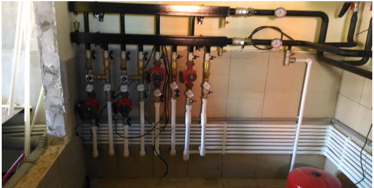
Окончание работ по обвязке оборудования в котельной
