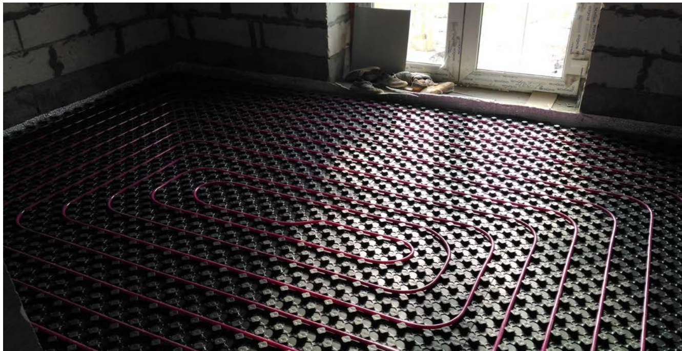
Монтаж контура теплых полов.
