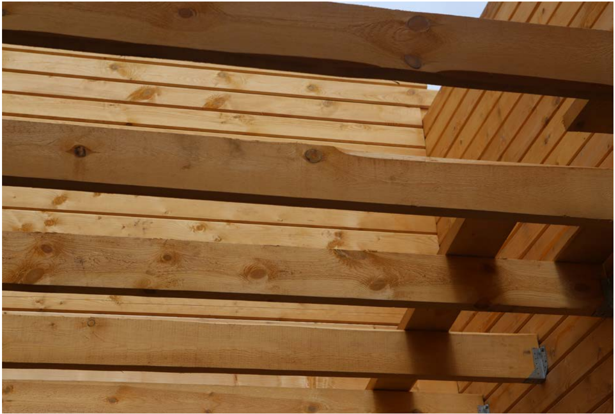
Пороки древесины на балочных элементах
