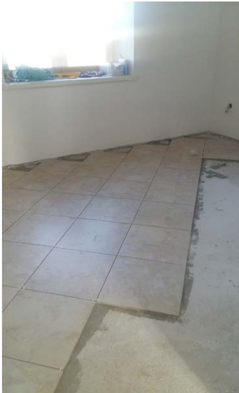
Укладка плитки на полы 1-го этажа.
