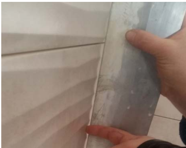
Проверка качества выполненных работ
