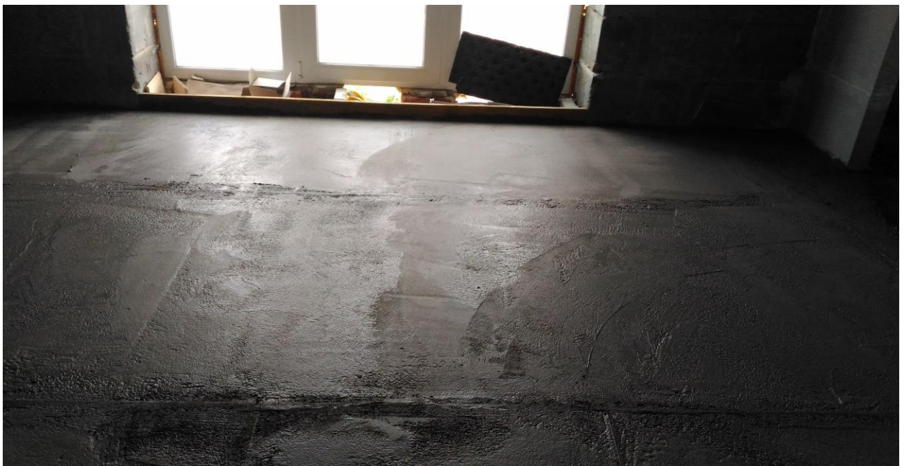
Устройство стяжки теплых полов
