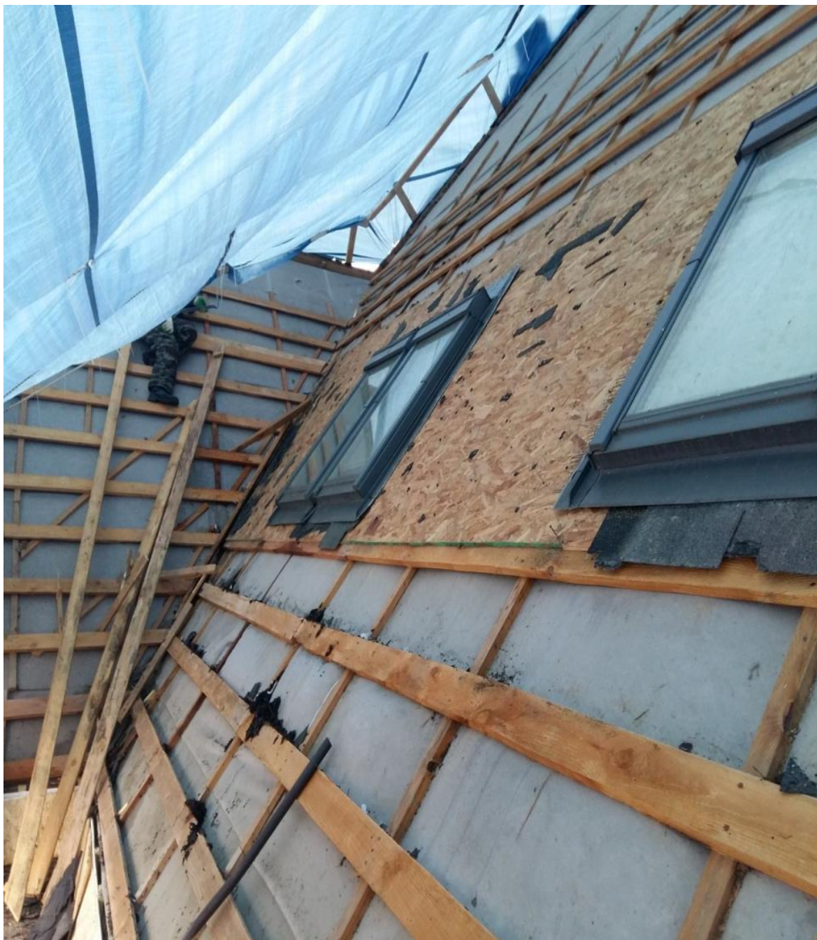
Фото2. Демонтаж кровельного покрытия.
