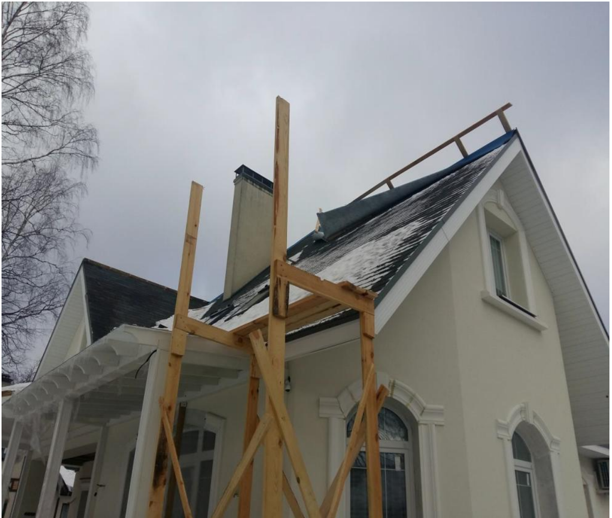
Фото1. Устройство лесов для демонтажа кровельного покрытия
