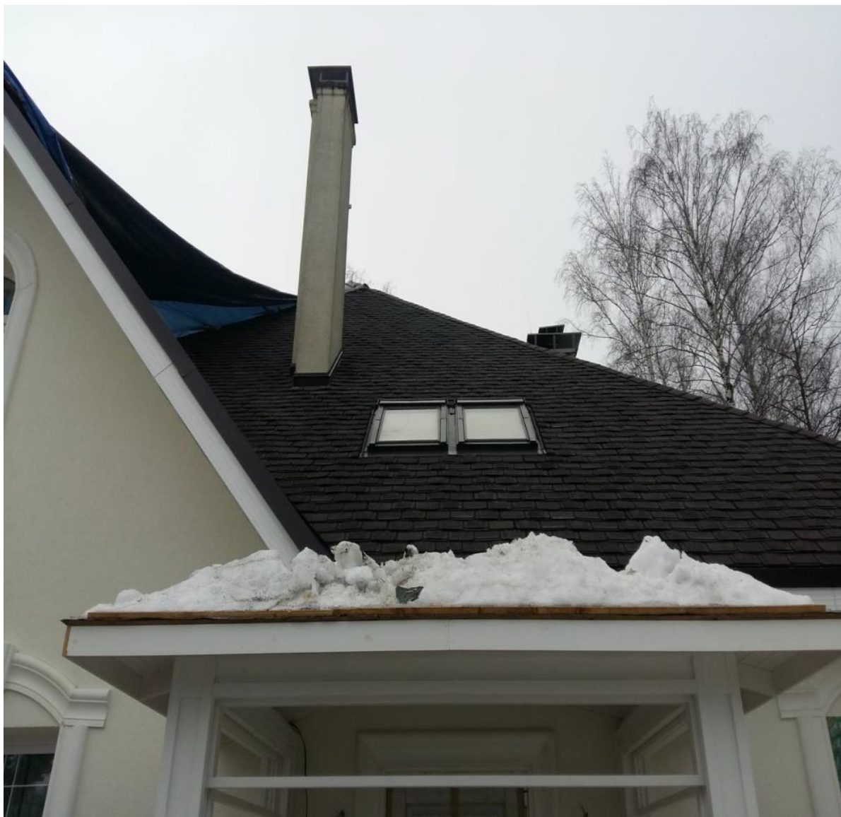
Фото 3. Смонтированное кровельное покрытие
