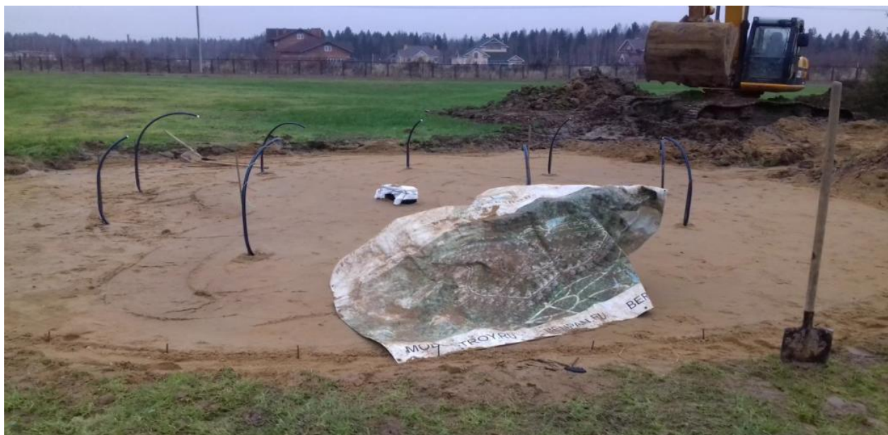
Устройство песчаного основания фонтана
