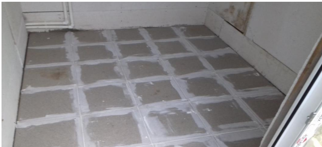
Устройство полов из керамической плитки в с/у зоопарка
