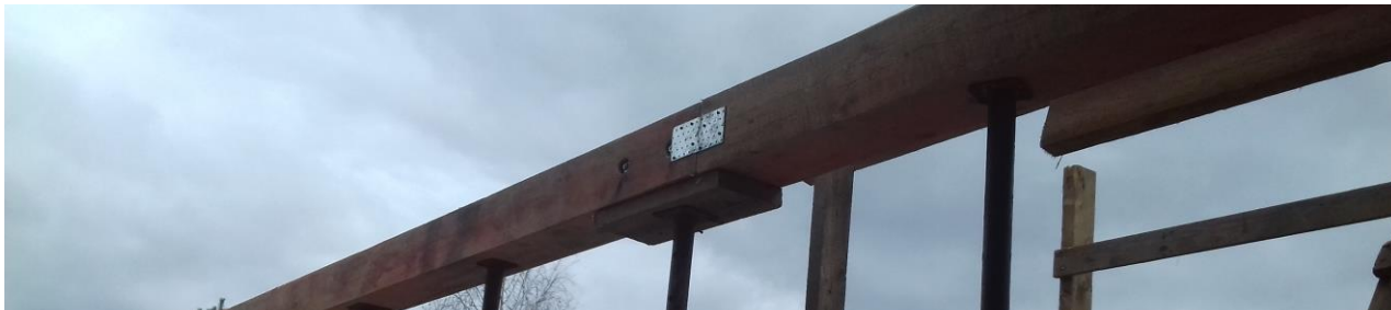
Монтаж балочной системы кровли
