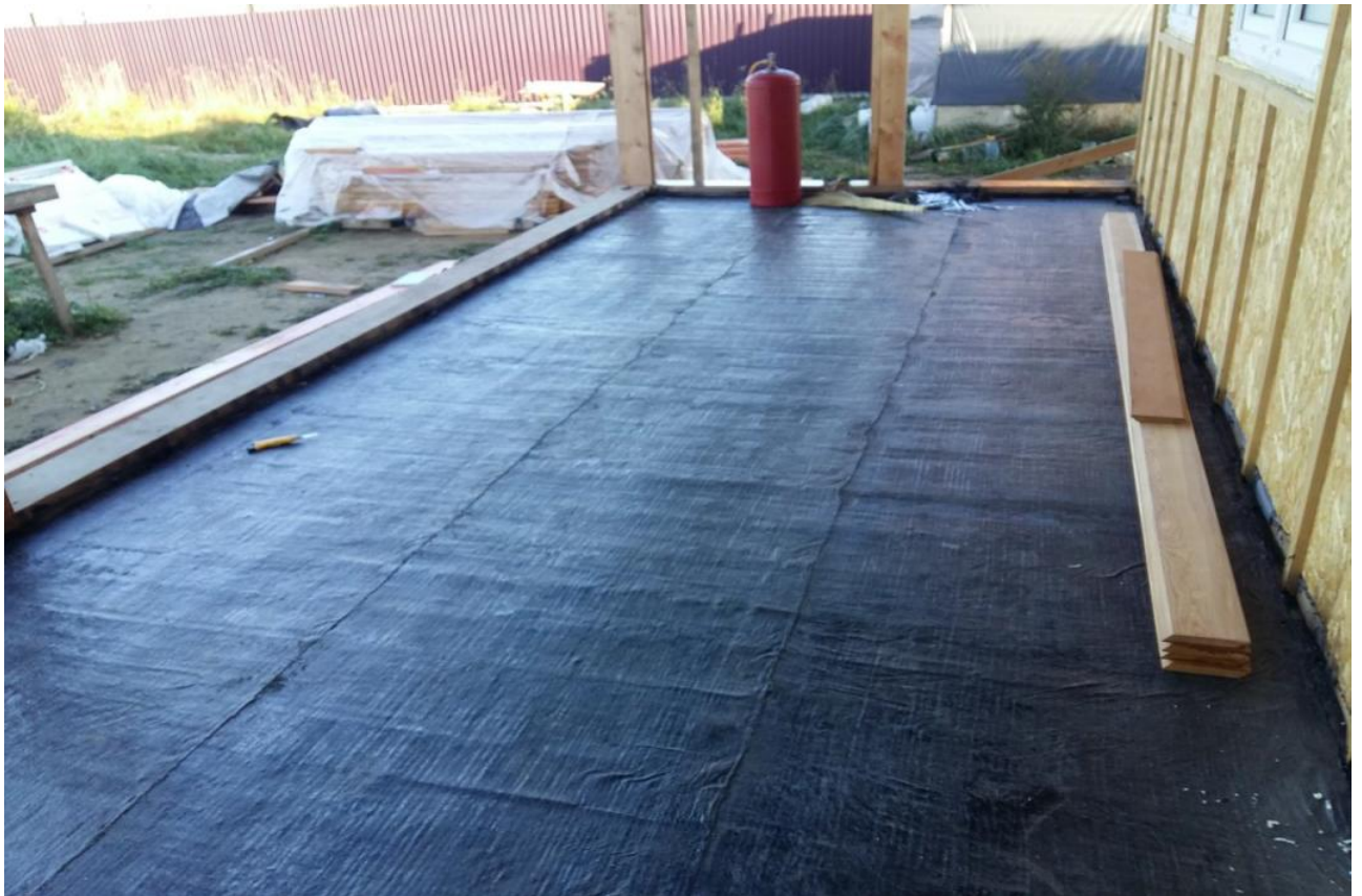
Устройство горизонтальной гидроизоляции фундаментов
