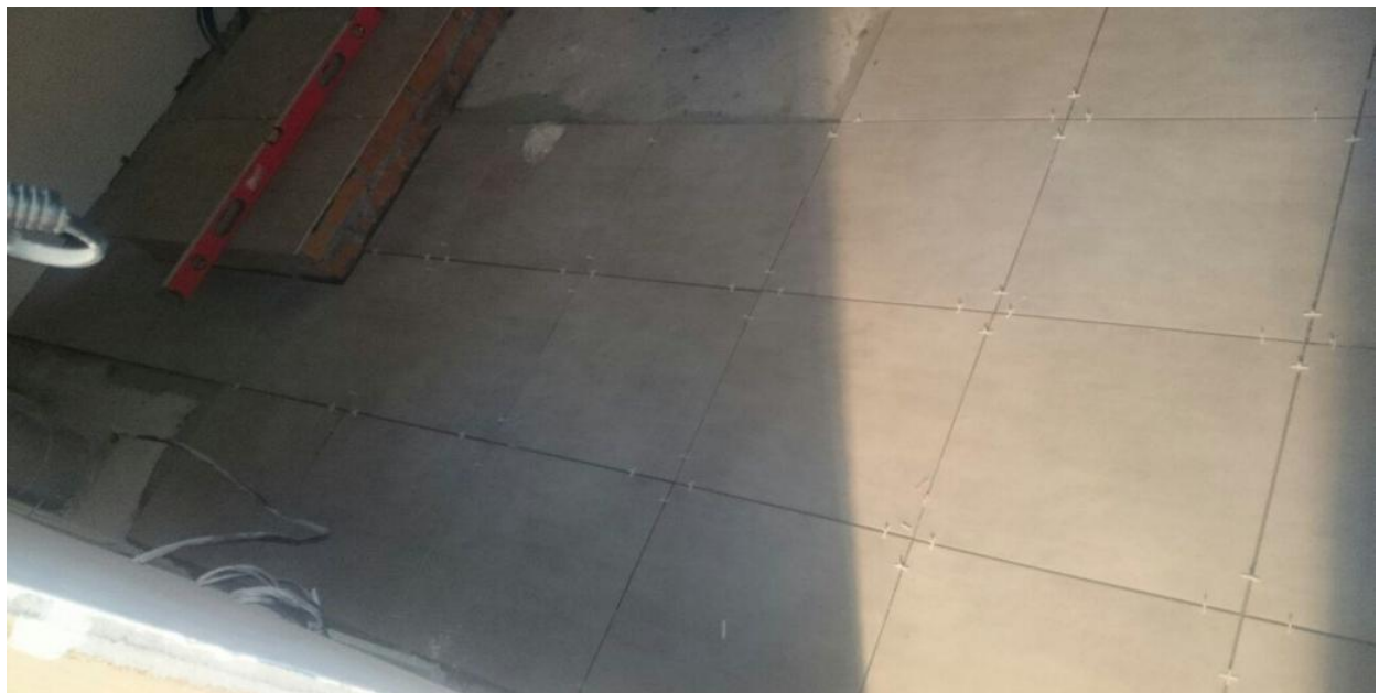
Плиточные работы в помещении котельной
