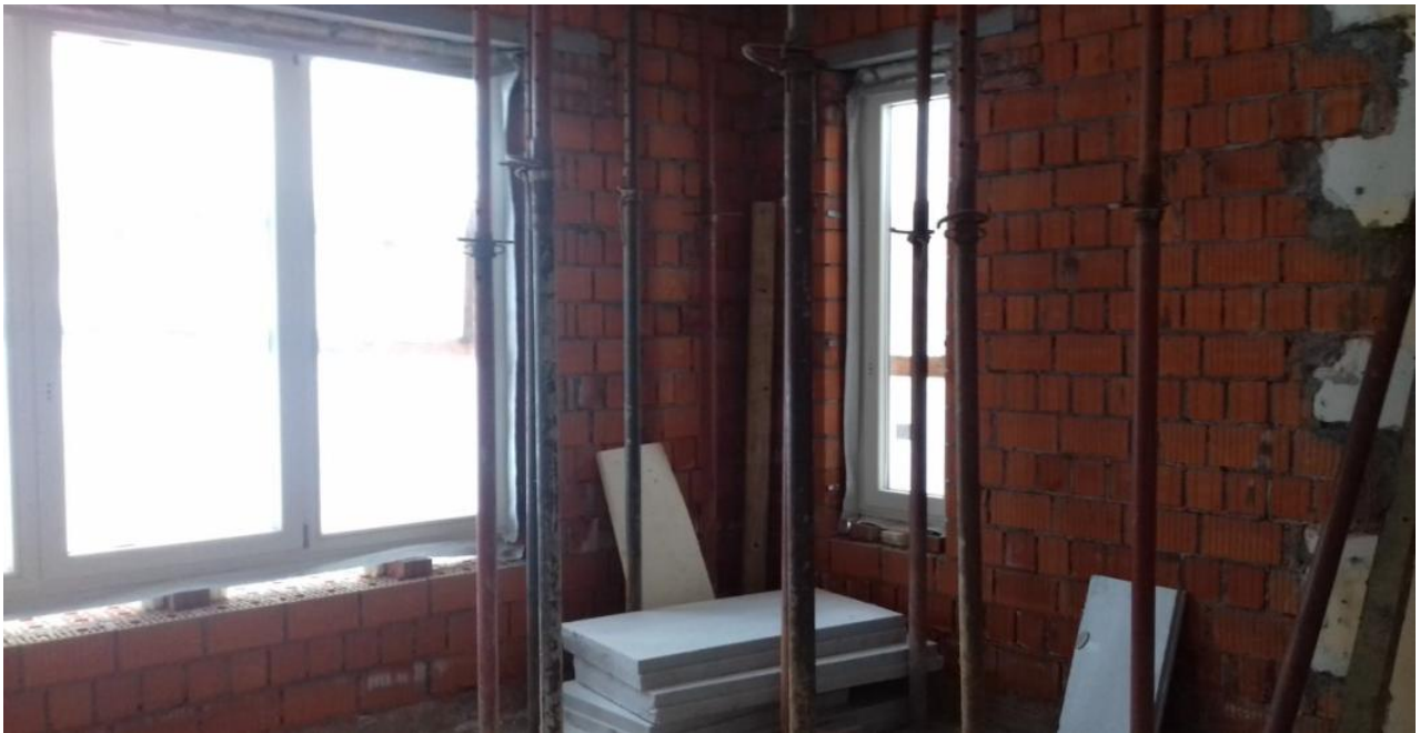
Монтаж оконных блоков (эркер 2 этаж)
