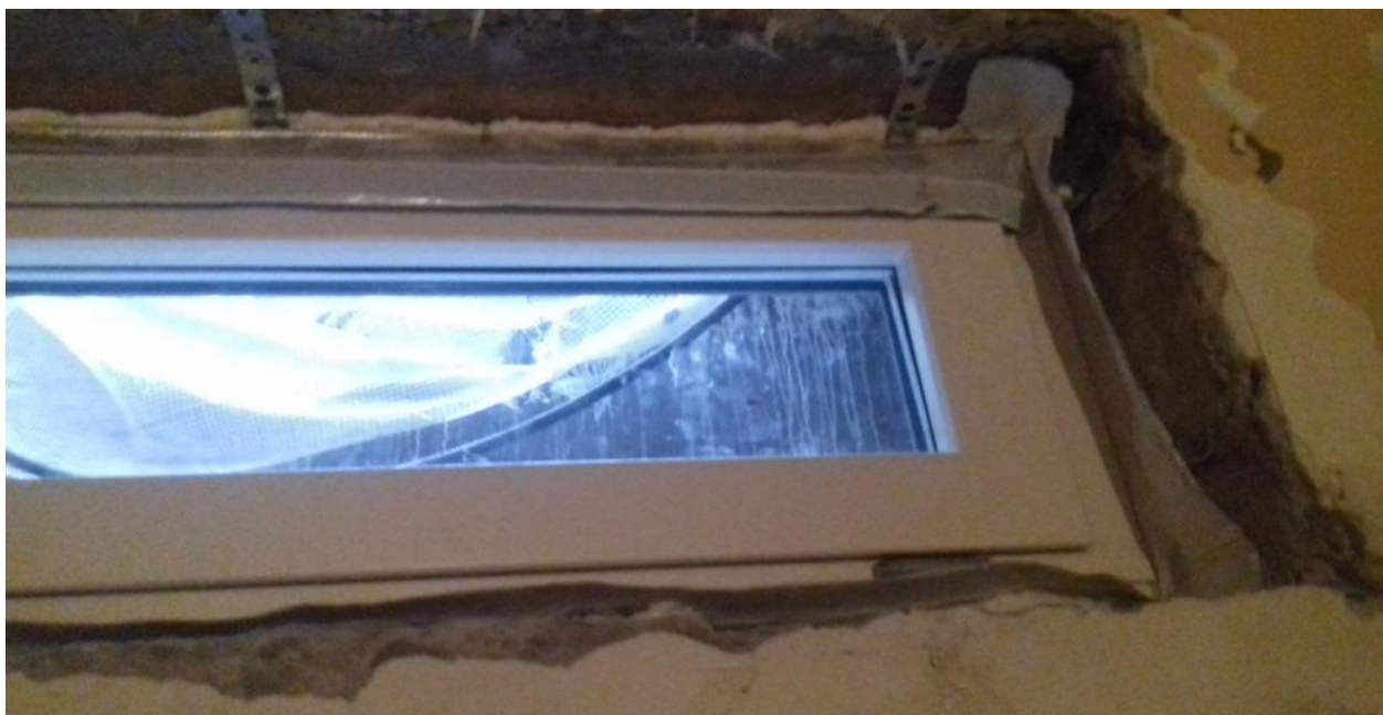
Установка оконных блоков подвала
