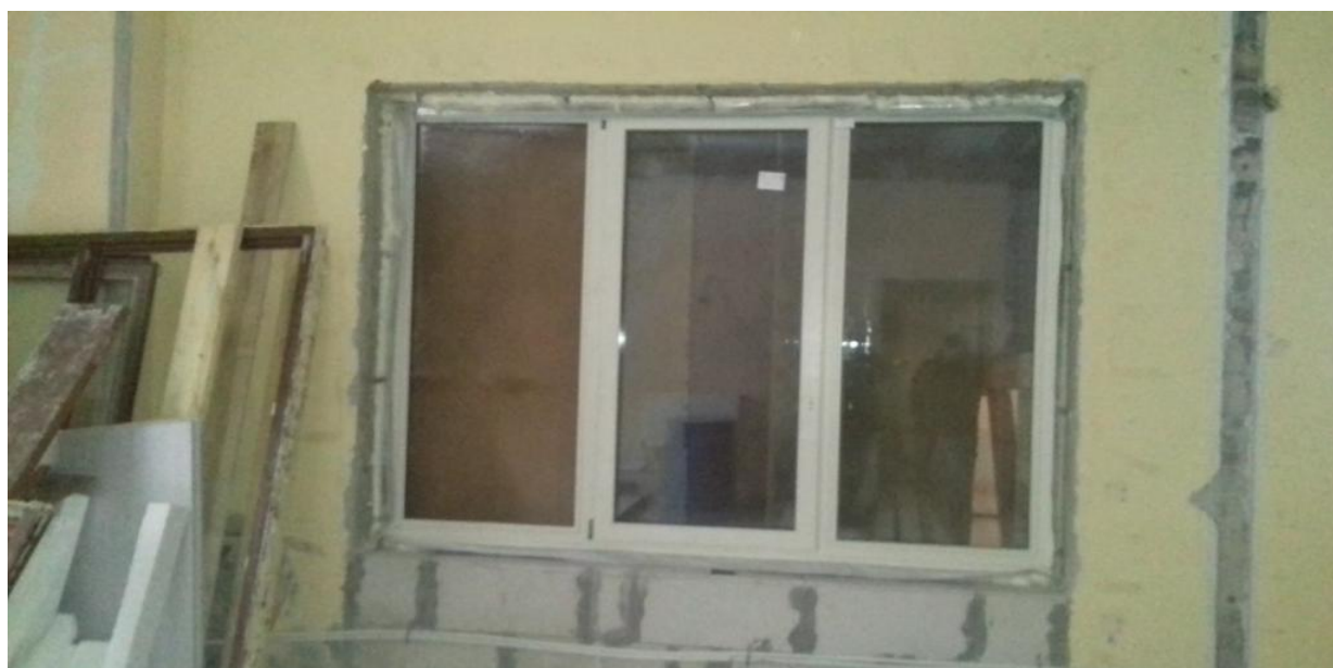
Установка оконных блоков 1 и 2 этажей.
