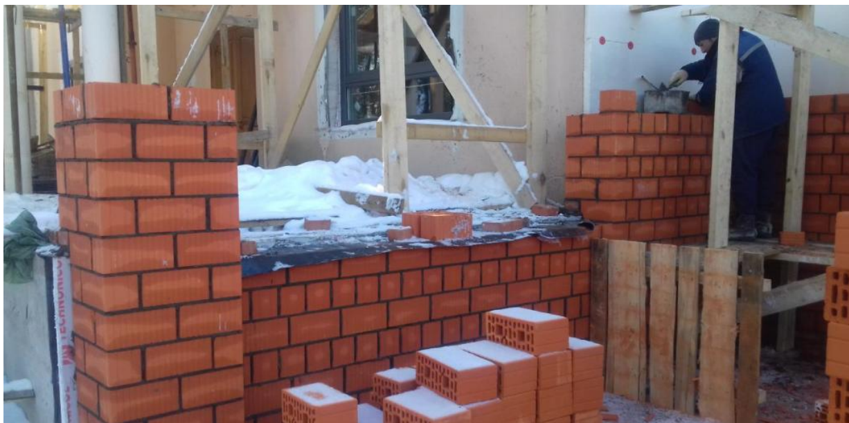
Кирпичная кладка стен террасы
