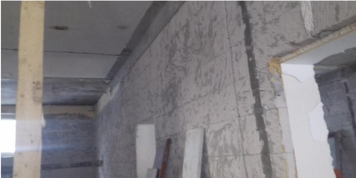
Демонтаж штукатурки стен 2 этажа
