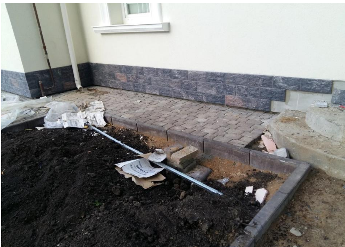
Устранение замечаний по дефектам отмостки
