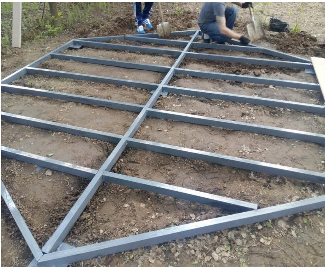
Монтаж металлоконструкций и террасной доски беседки
