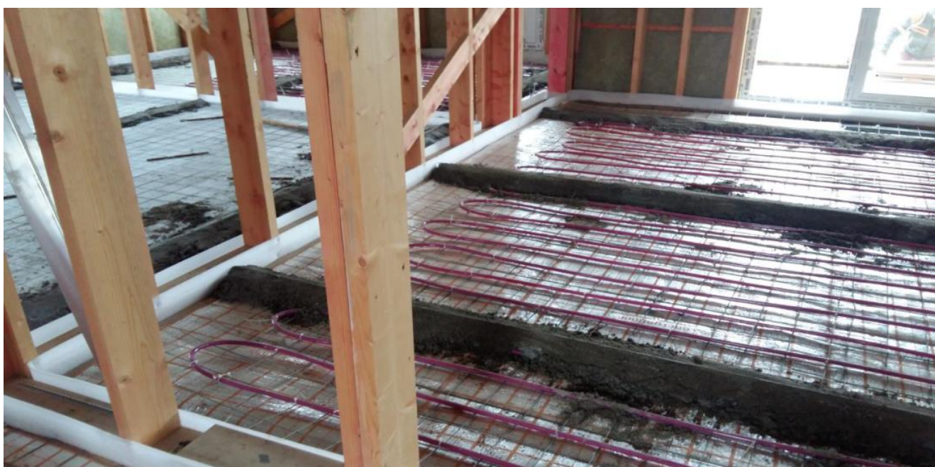
Установка маяков теплых полов
