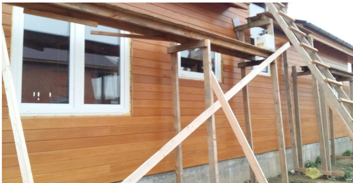
Монтаж планкена на фасад
