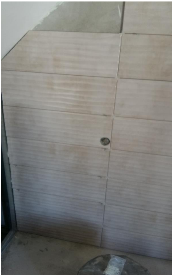
Облицовка плиткой стен с/у.
