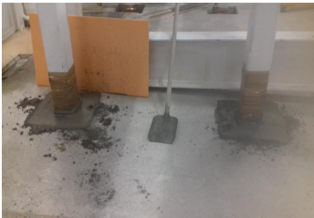
Бетонирование стаканов фундаметов
