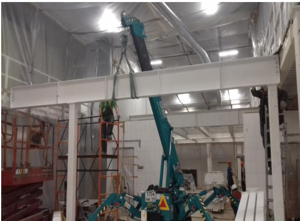
Монтаж каркаса
