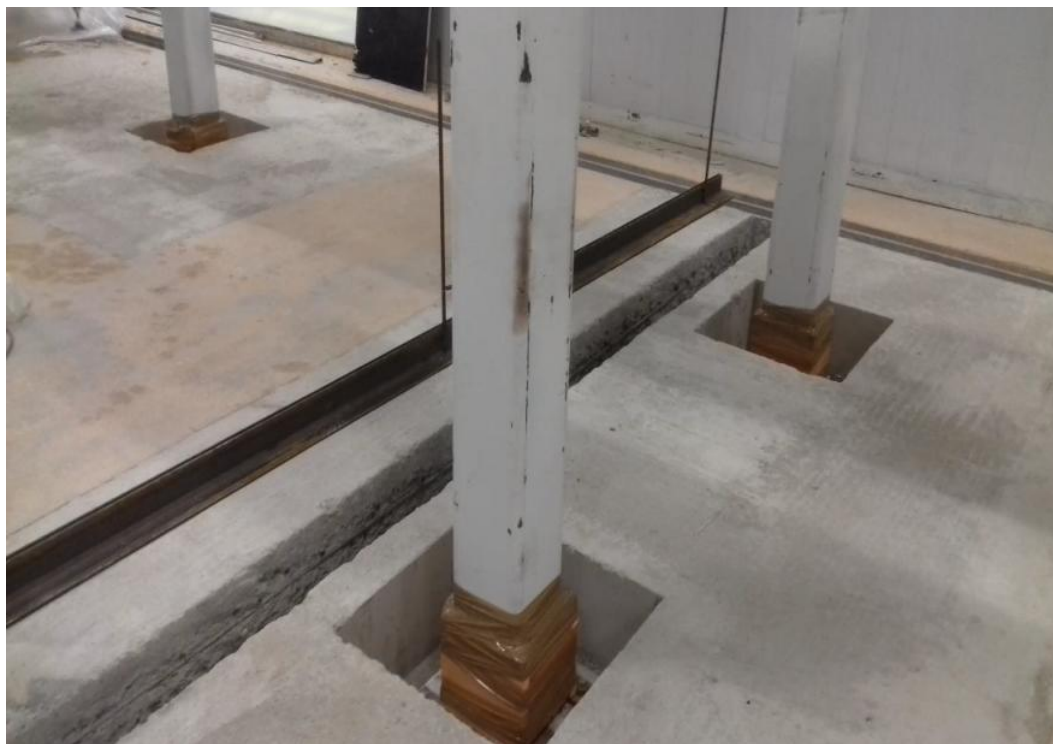
Бетонирование стаканов фундаметов
