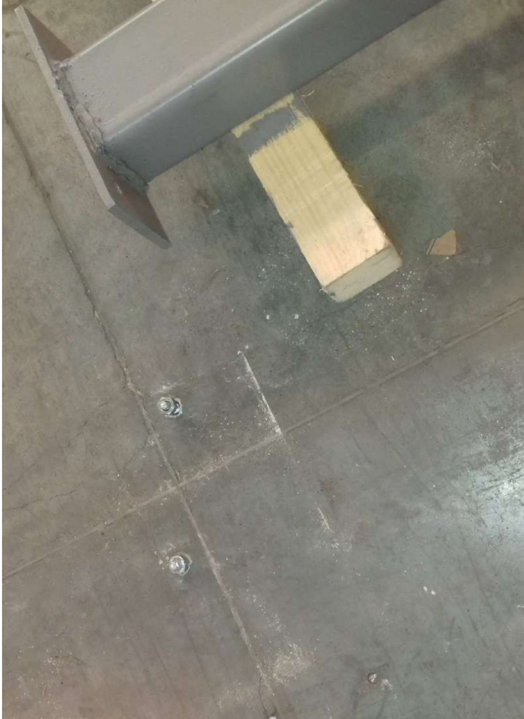
Установка анкер-болтов.
