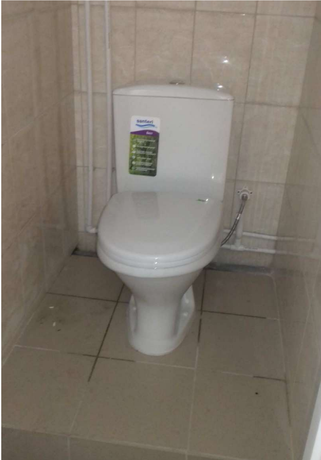
Установка сантехприборов в санузлах.
