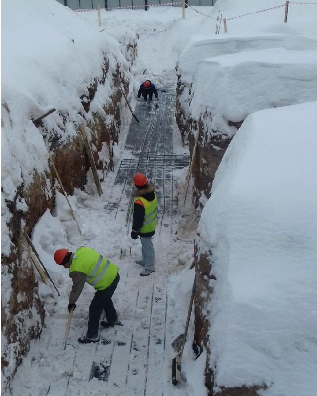
Раскладка нижней армирующей сетки подошвы фундамента, 28.01.2019.
