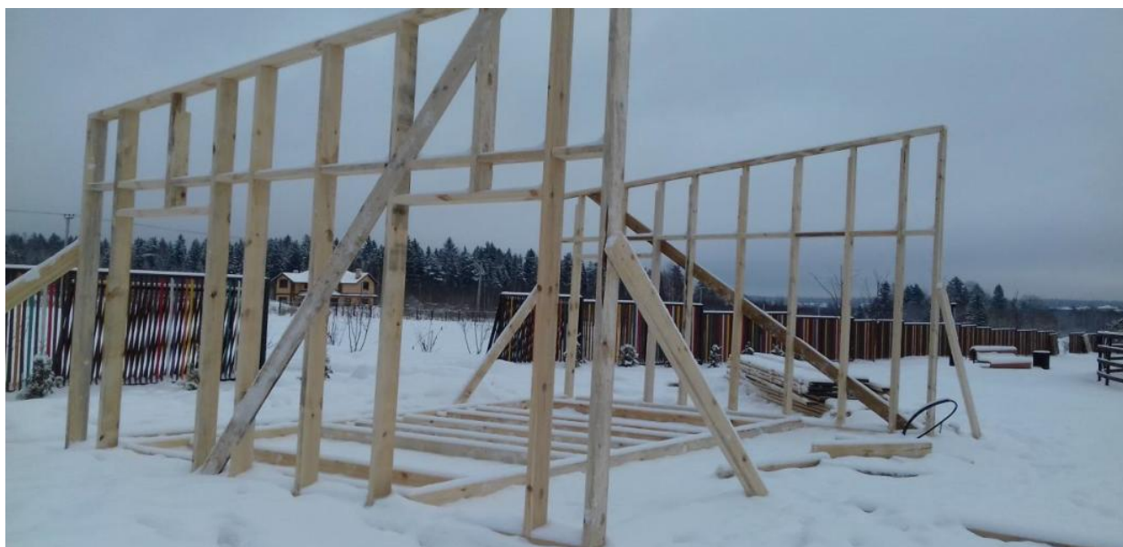
Монтаж каркаса беседки
