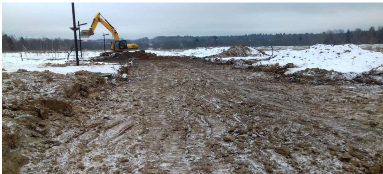
Устройство корыта дорожного покрытия
