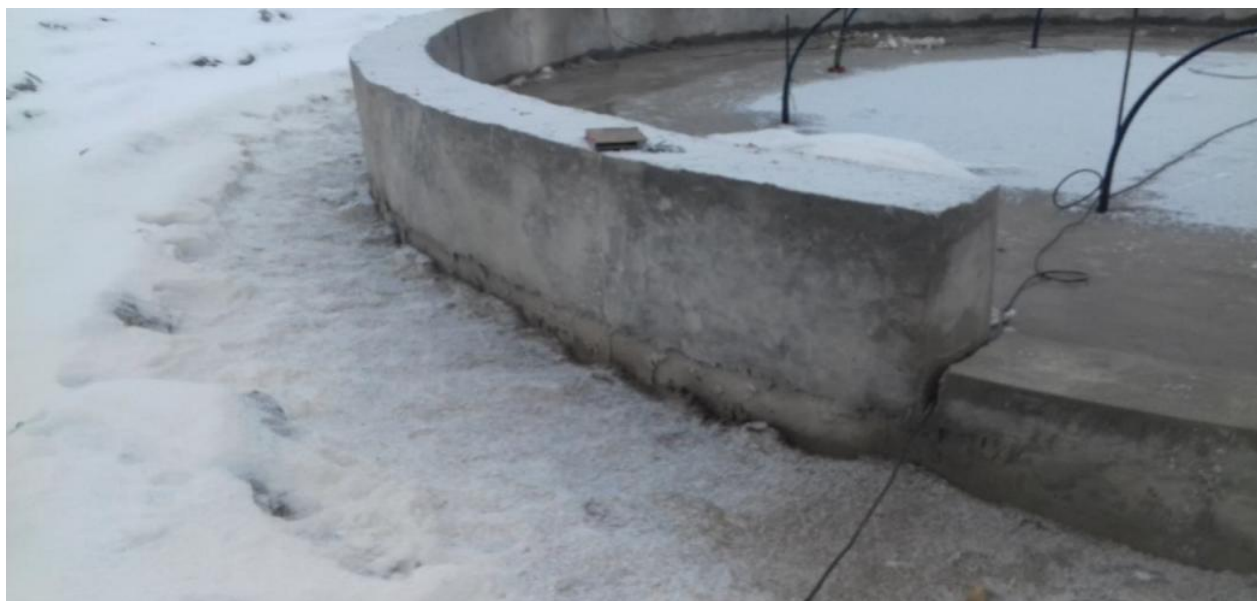
Шлифовка стен фонтана.
