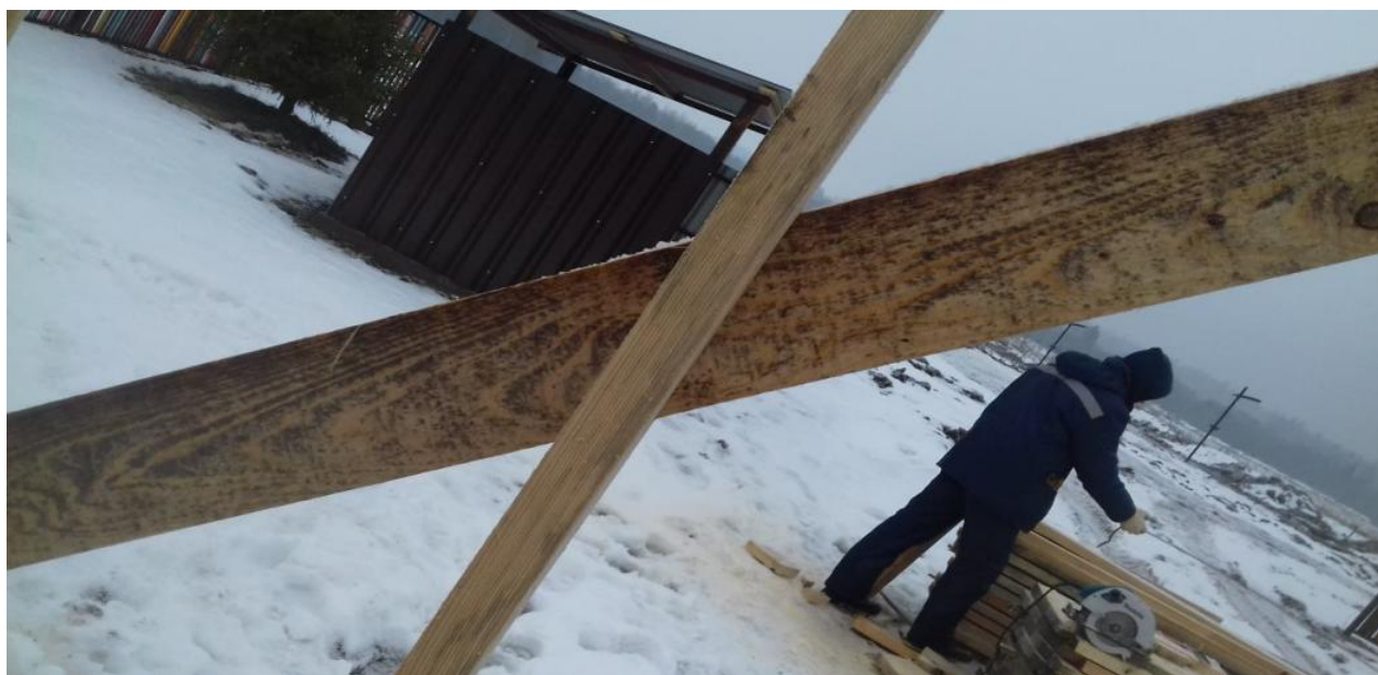
Обзол и плесень деревянного каркаса подсобного помещения зоопарка
