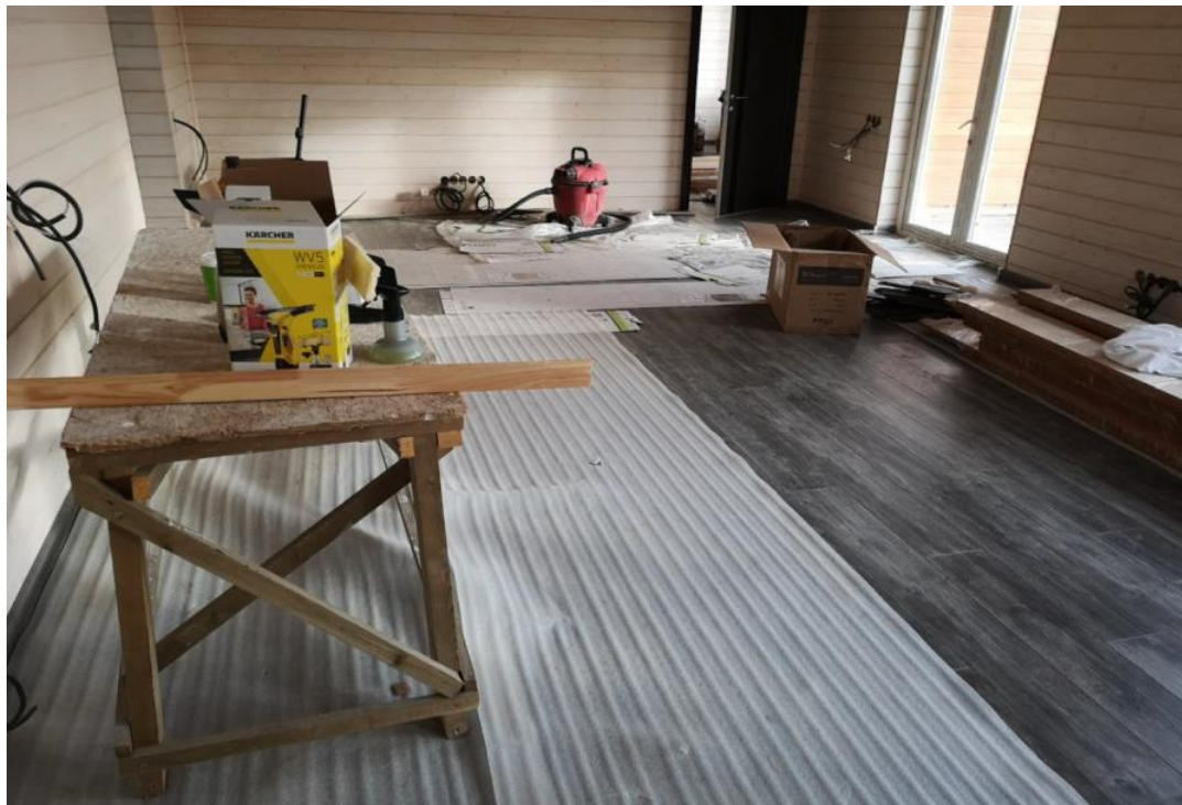
Защита напольного покрытия при ведении работ, 07.06.2018.
