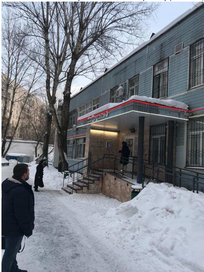
Линейный светильник установлен не по проекту (лист ГЧЗ, вид 1).
