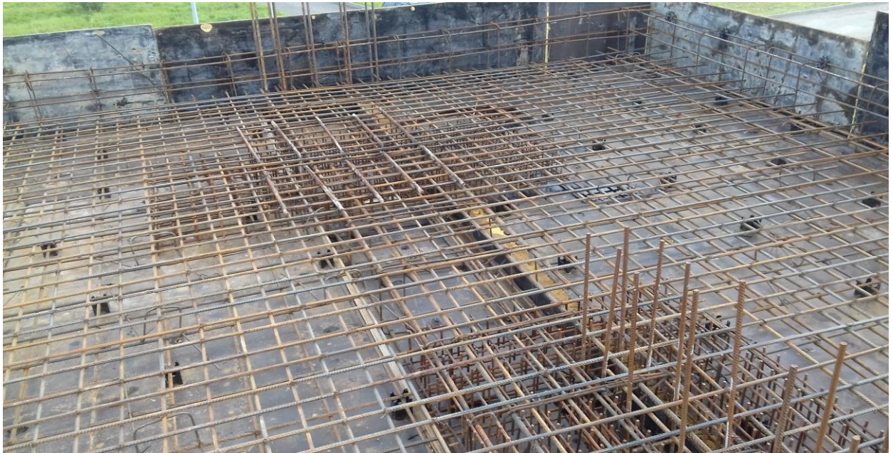
Фото1. Армирование плиты 1-го этажа
