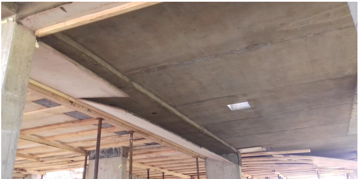
Демонтаж опалубки плиты перекрытия 1-го этажа.
