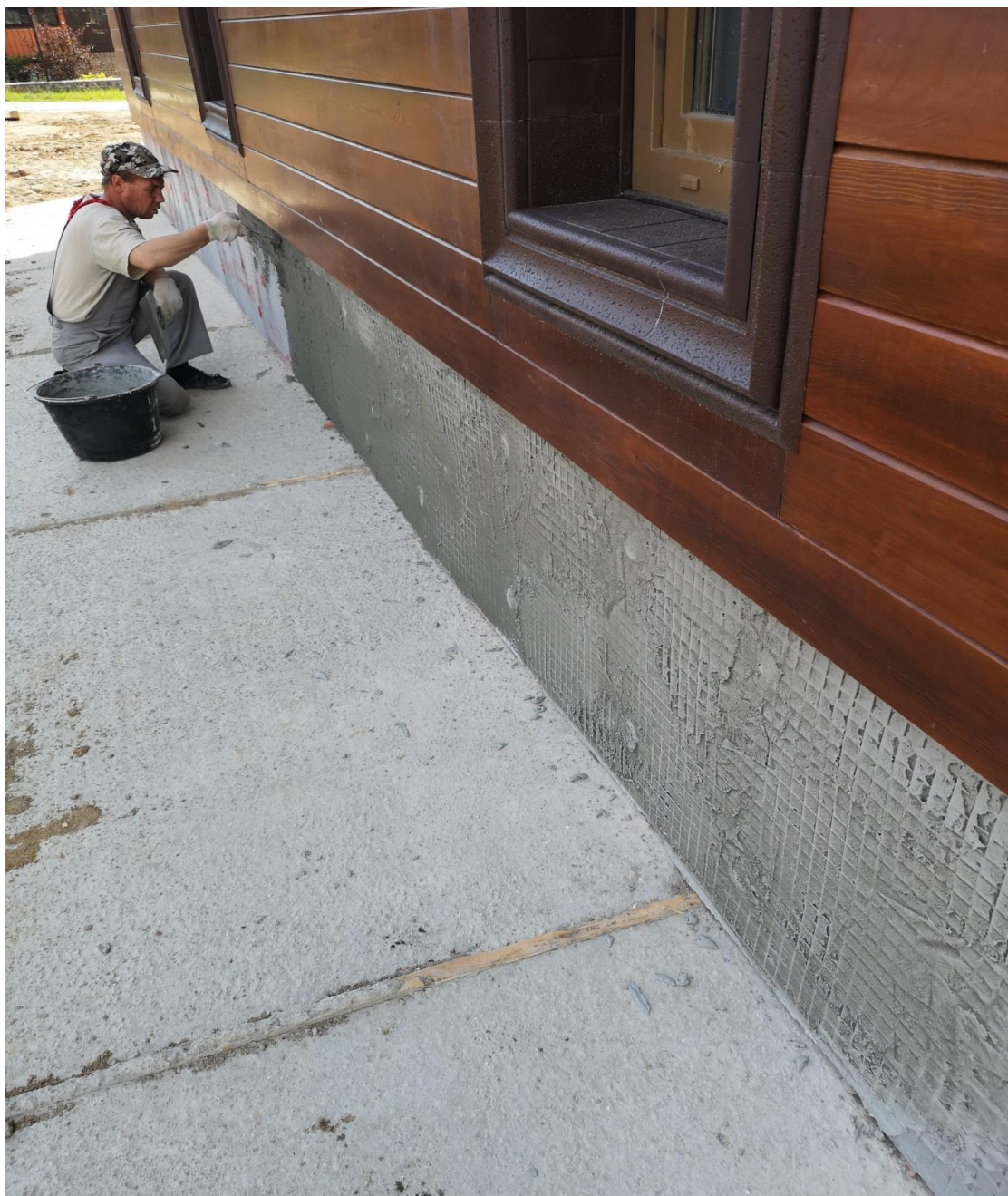
Оштукатуривание цоколя по сетке.
