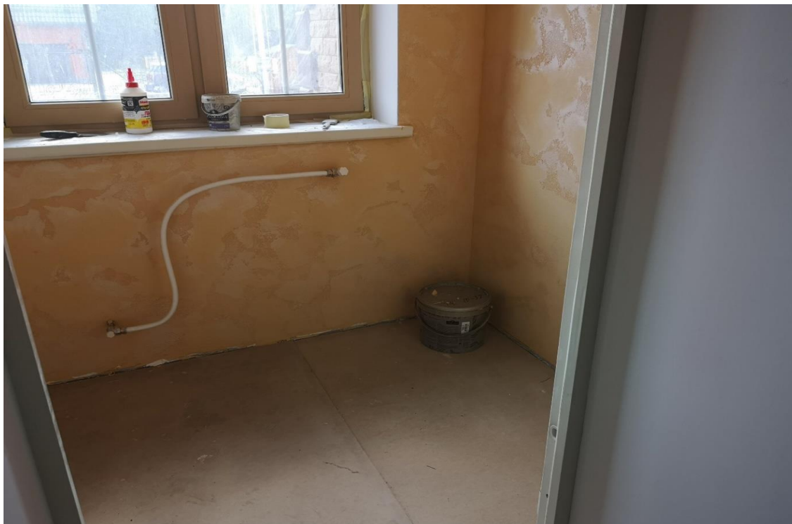
Декоративная штукатурка в тамбуре, 29.06.2018.
