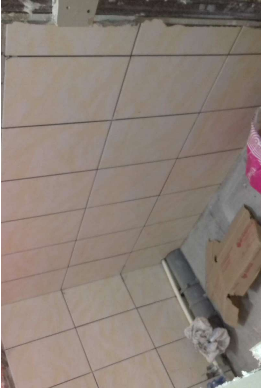
Облицовка плиткой санузла №2.
