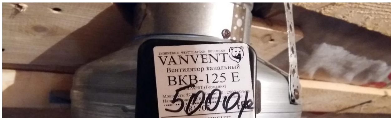
Монтаж системы вентиляции
