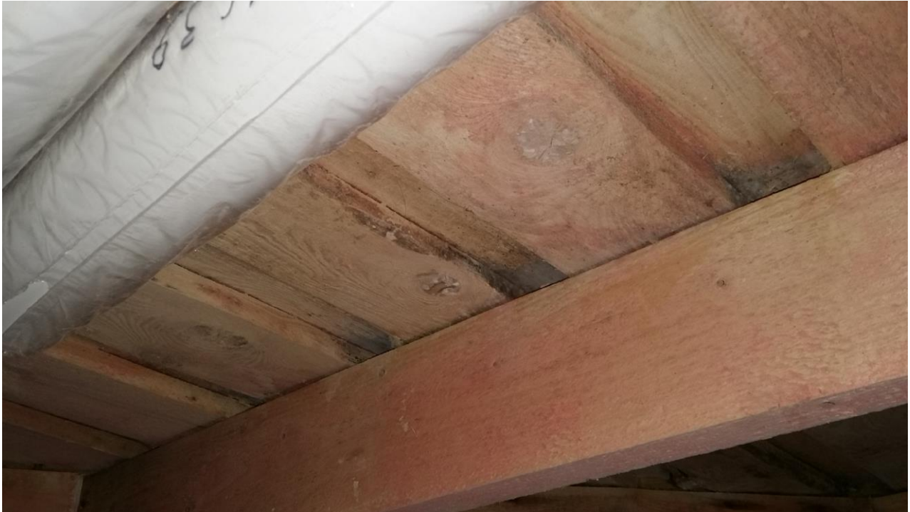
Плесень и грибок на стыках обшивки потолка и под лагами потолка
