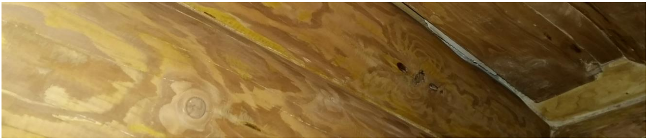
Плесень и грибок на стыках обшивки потолка и под лагами потолка
