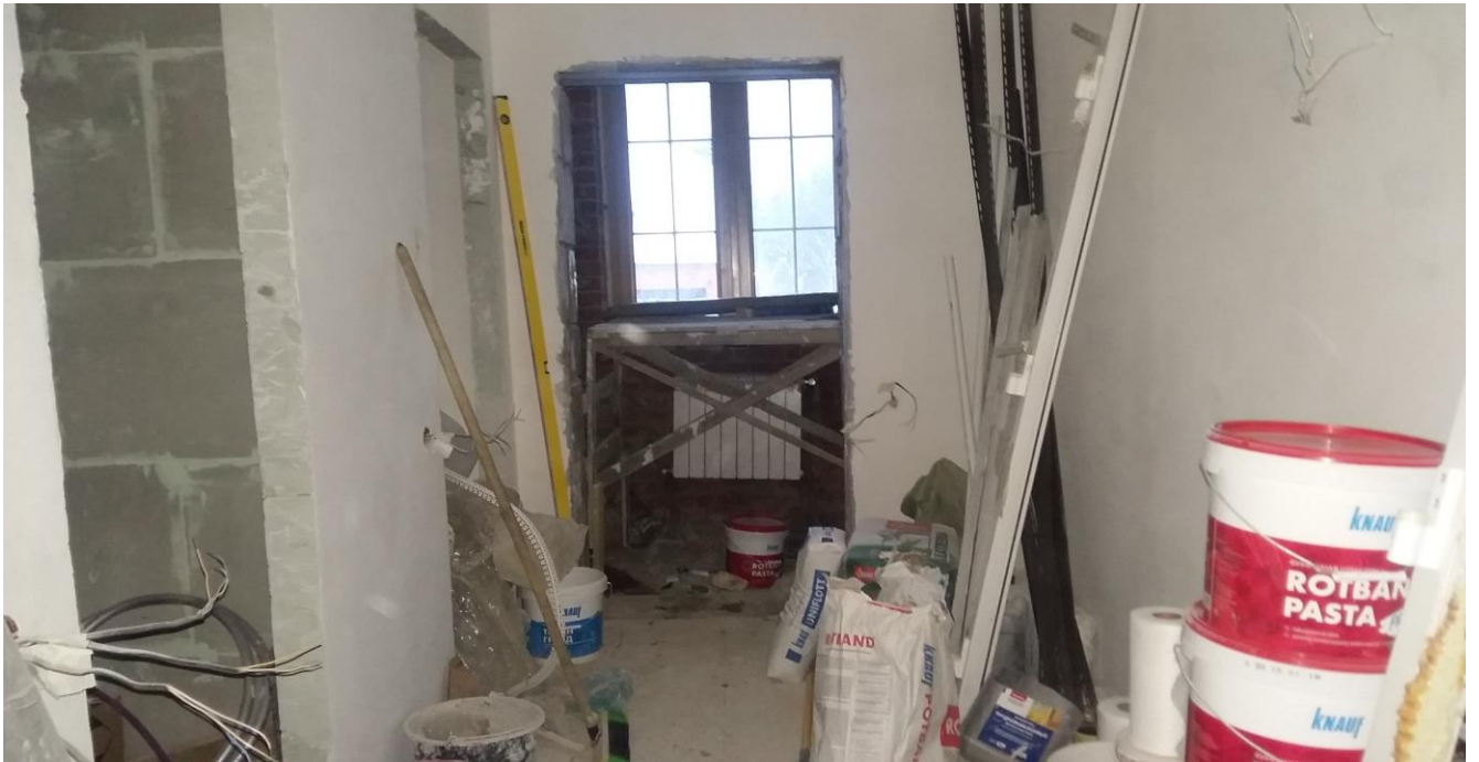
Внутренняя отделка стен
