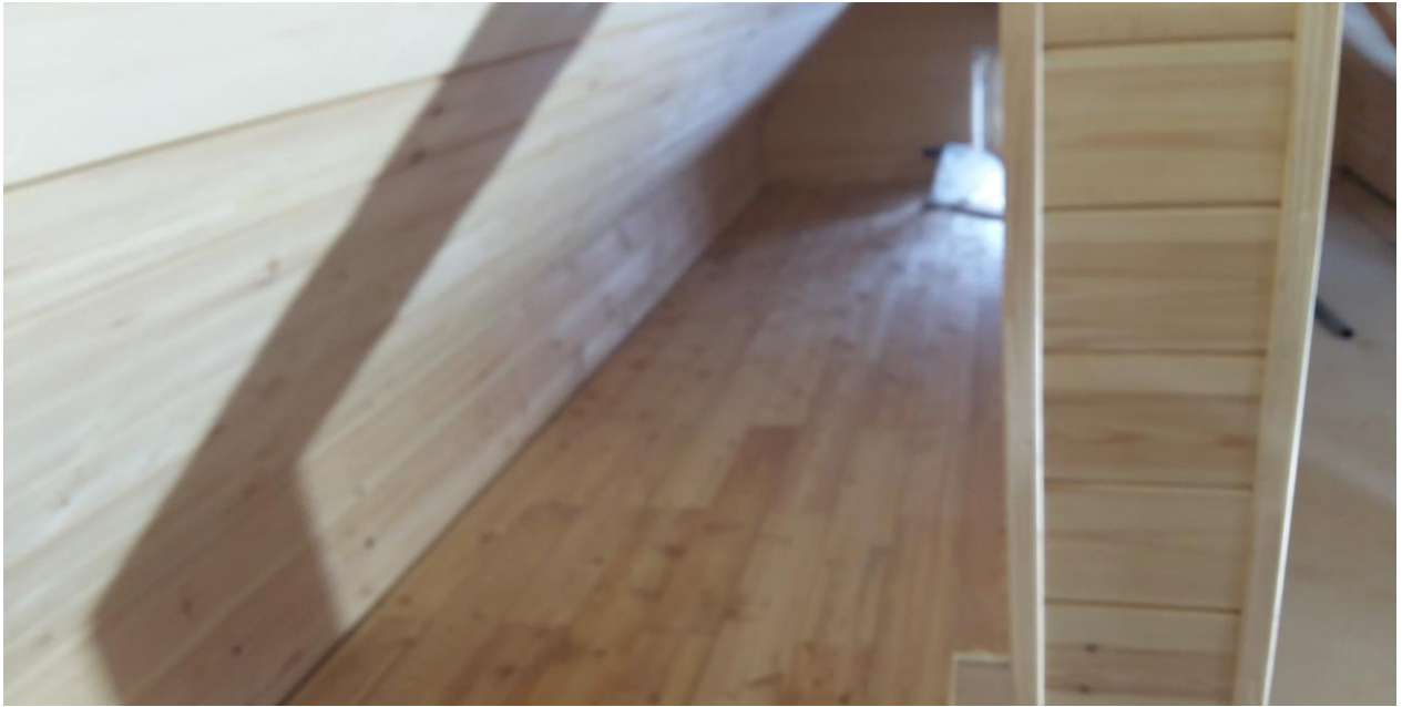
Обшивка доской полов и стен чердака
