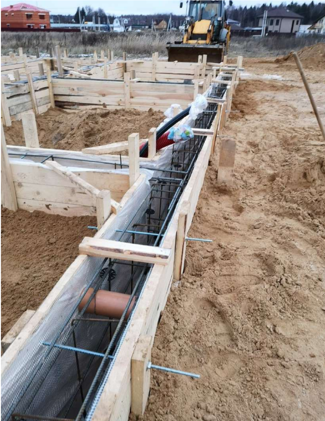
Арматурный каркас после устранения замечаний.
