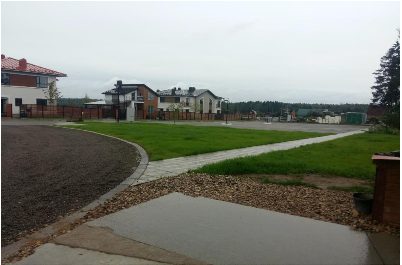
Устройство наружной канализации
