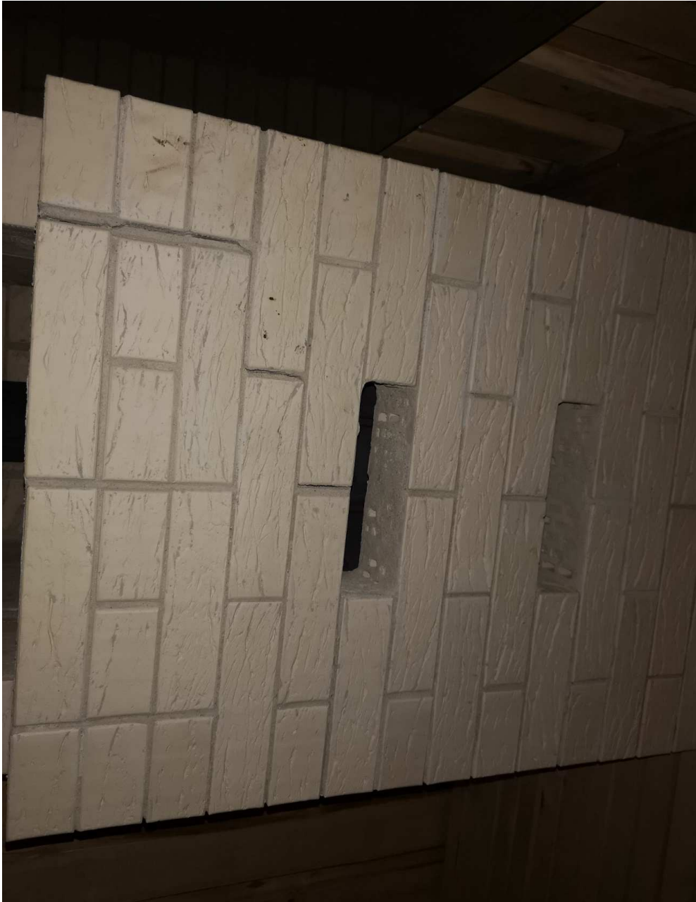
Разрушение печи.
