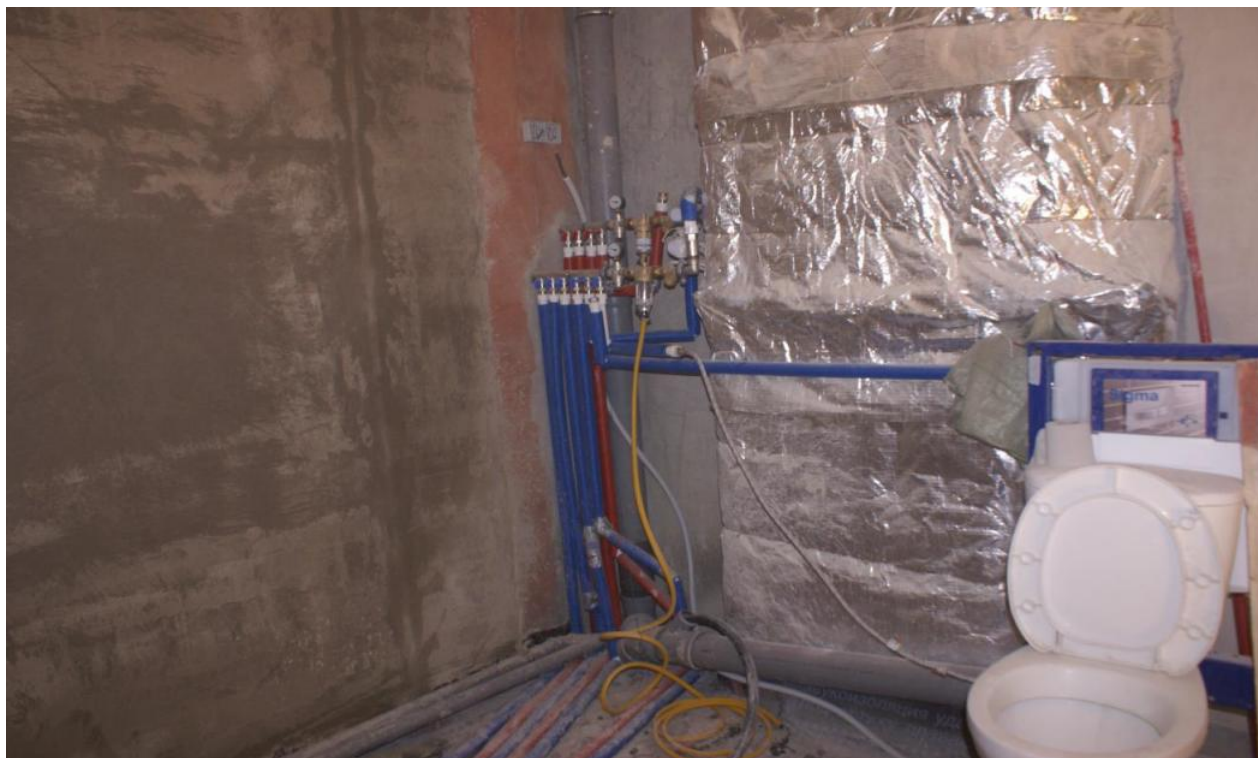
Монтаж сантехнических разводов
