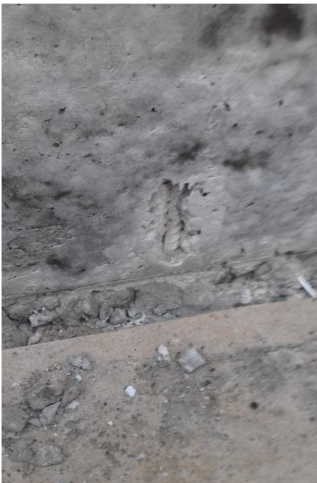
Дефекты бетона после распалубливания
