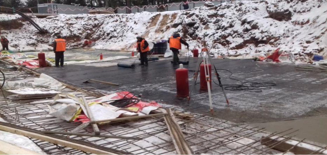
Устройство гидроизоляции в осях А-В/4-2
