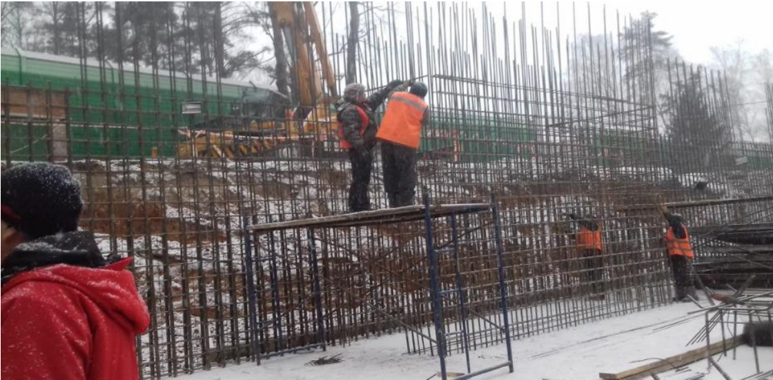
Армирование стен цоколя
