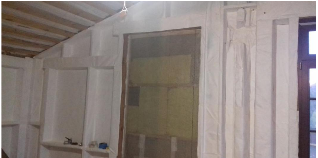
Обшивка наружных стен 2-го этажа пароизоляцией.
