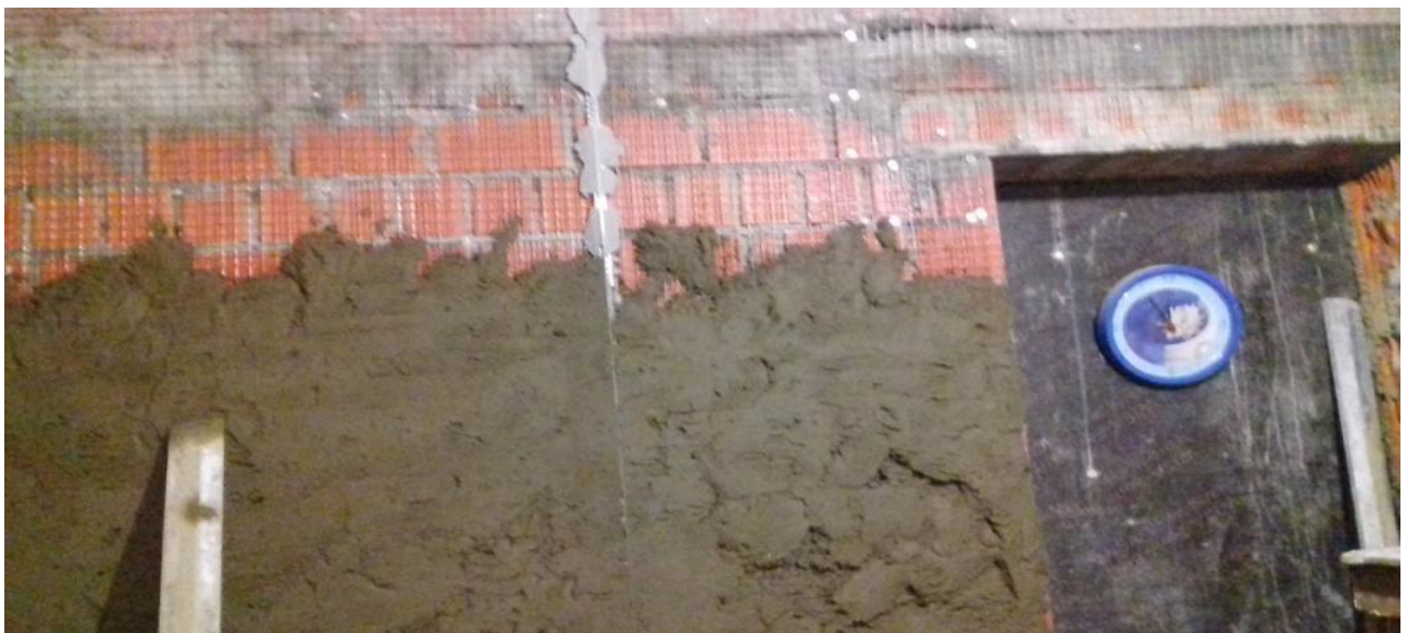
Штукатурка стен подвала
