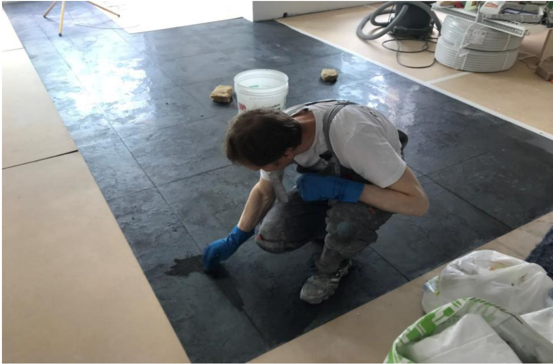
Затирка и отмывка керамогранитной плитки, 27.06.2018.
