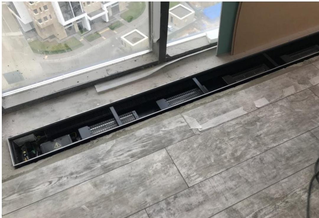
Укладка керамогранитной плитки, 08.06.2018.
