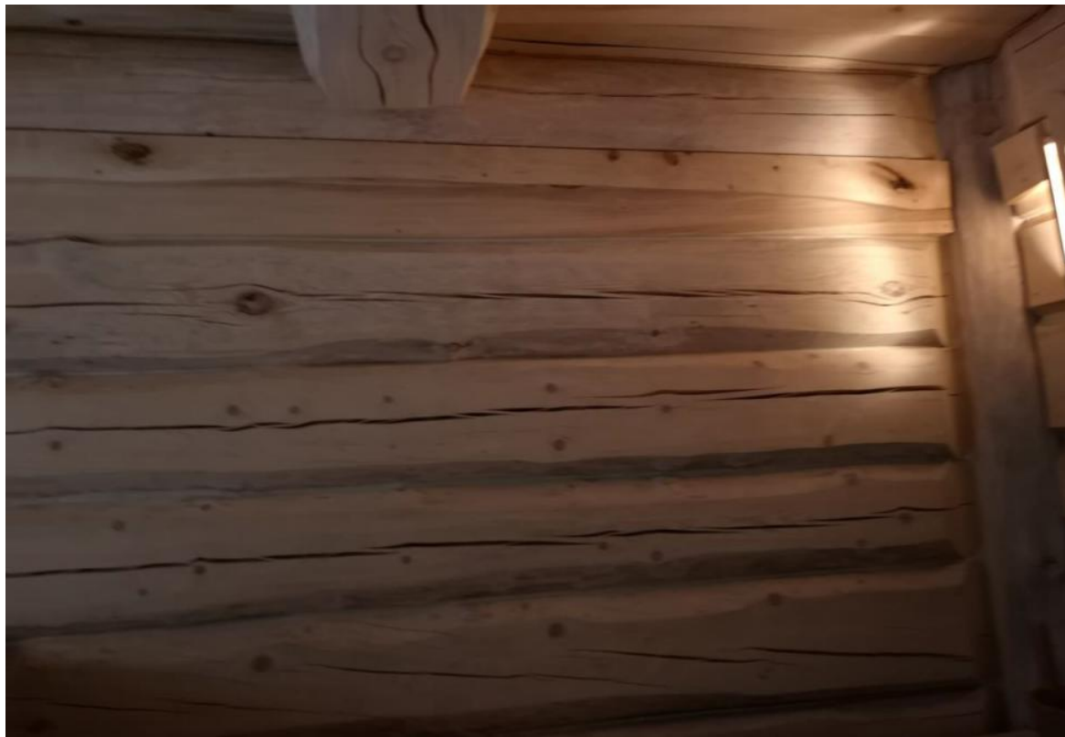
Внутренняя поверхность наружной стены, 05.06.2018.
