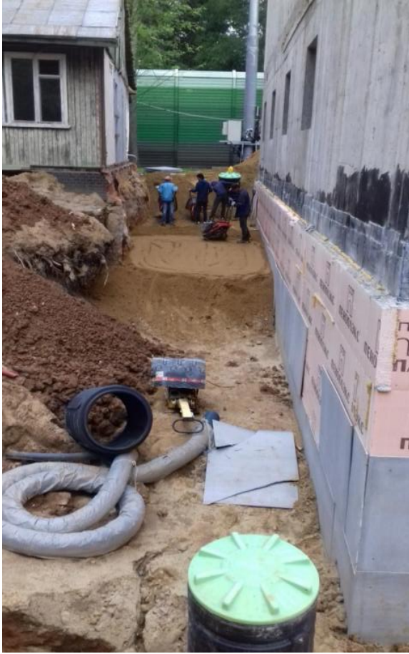
Засыпка с послойной трамбовкой.
