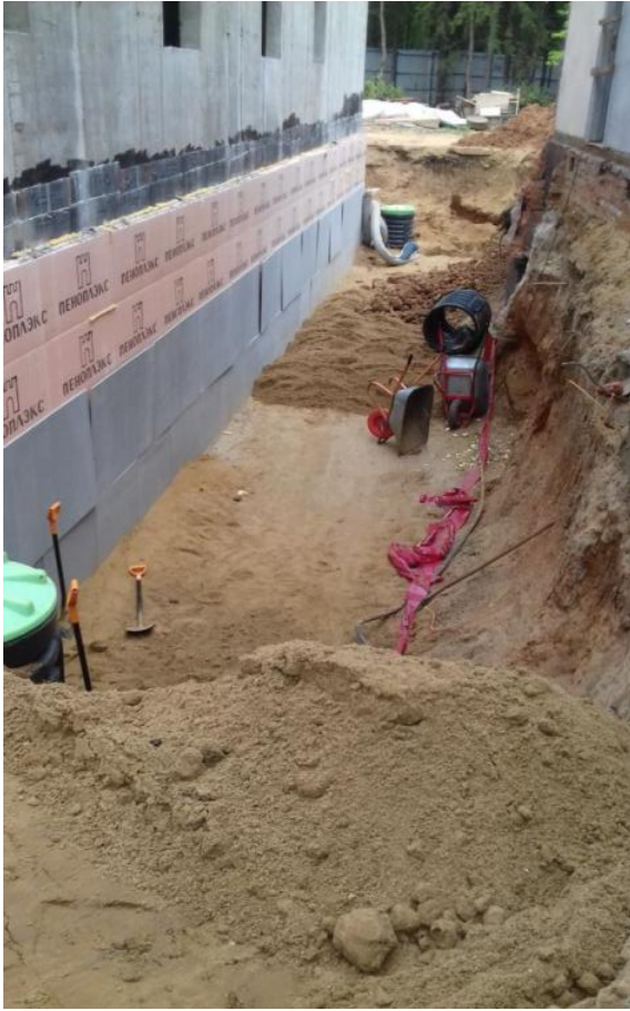
Укладка сигнальной ленты вдоль трассы электрокабеля.
