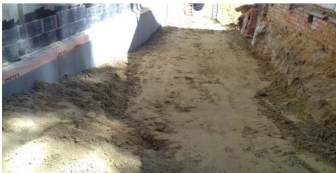
Засыпка с трамбованием.
