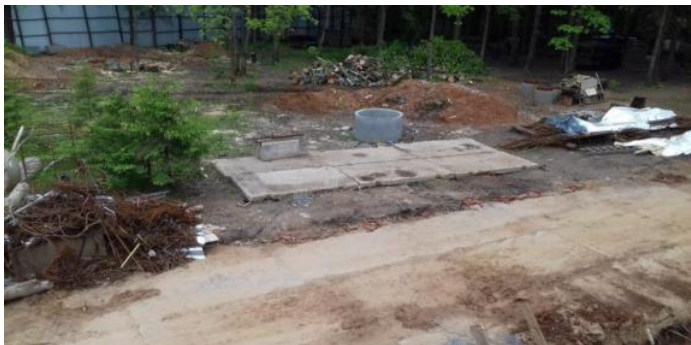
Демонтаж арматурного цеха.
