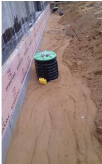
Засыпка котлована песком с послойной трамбовкой.
