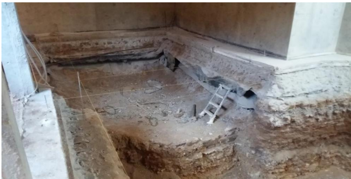
Выемка грунта чаши бассейна
