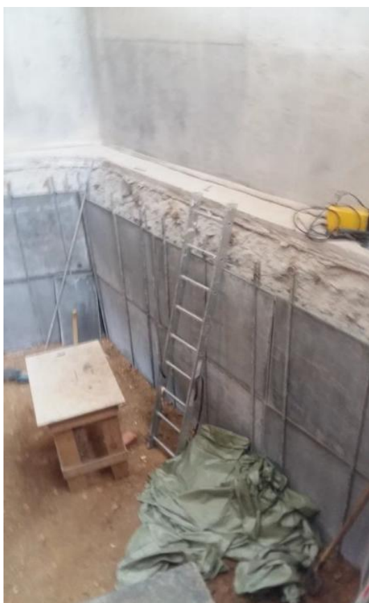
Устройство подпорной стенки
