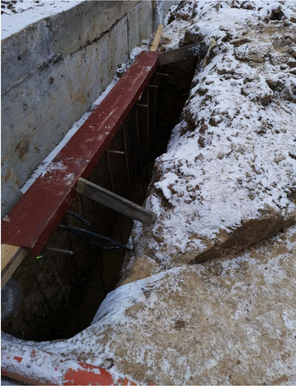
Устройство траншеи с закладными деталями.
