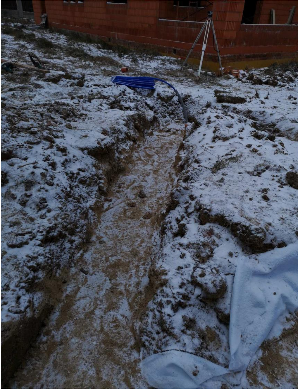
Обратная засыпка песком траншеи с коммуникациями.
