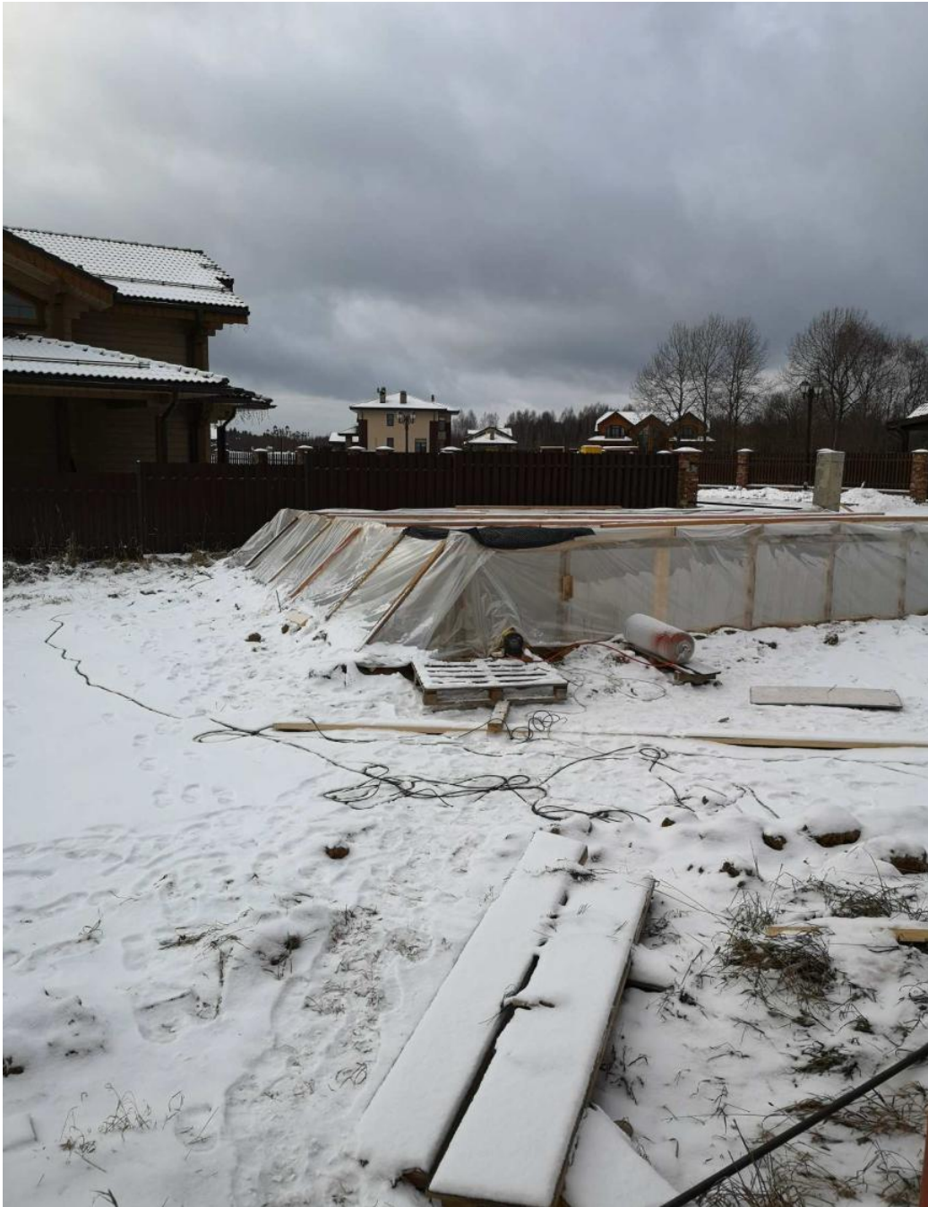
Уход за бетоном.
