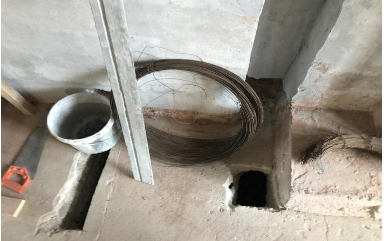
Устройство технологических отверстий для инженерных разводок.
