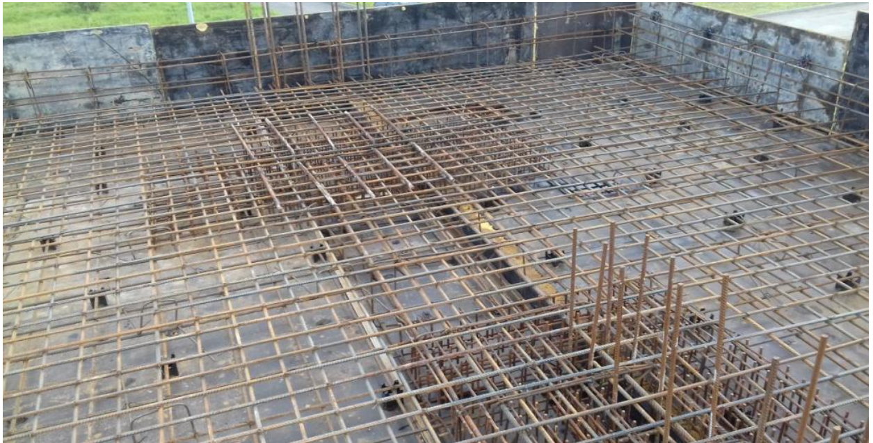
Фото1. Армирование плиты 1-го этажа
