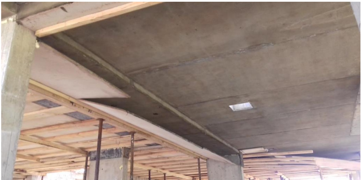
Демонтаж опалубки плиты перекрытия 1-го этажа.
