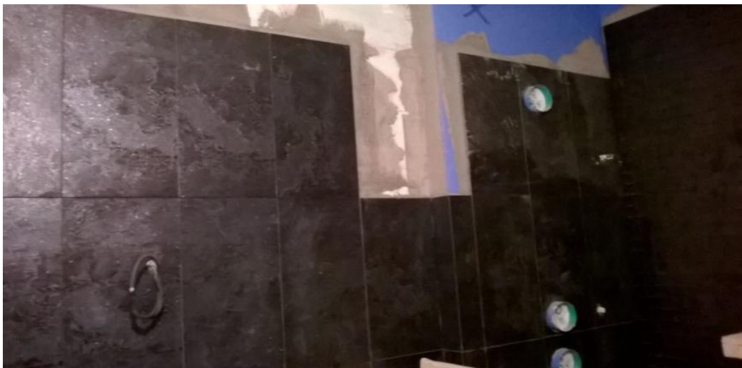
Монтаж керамогранита на стены су, 27.04.2018
