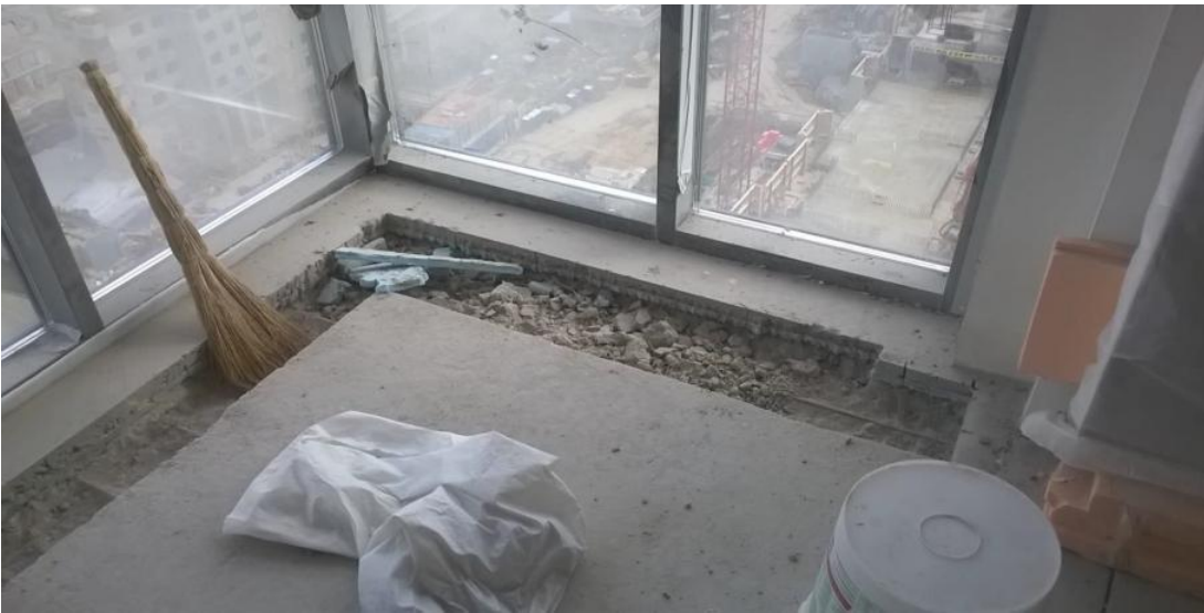
Демонтаж закладных под конвекторы, 27.04.2018
