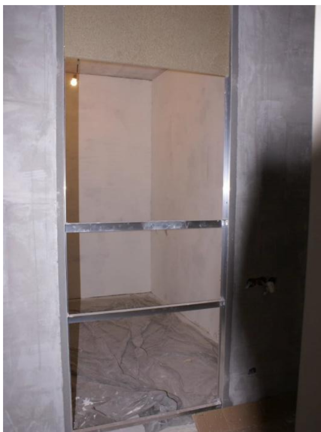
Установка направляющих, 09.04.2018
