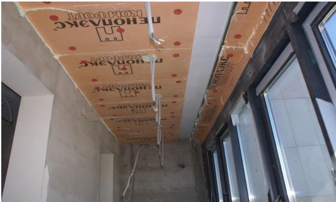
Утепление потолка балкона, 04.04.2018
