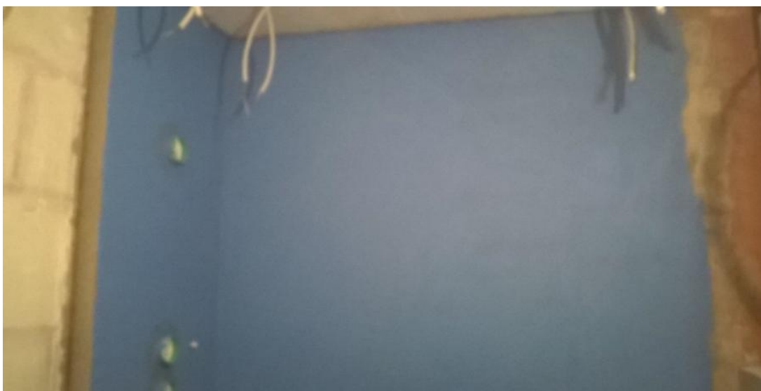
Устройство обмазочной гидроизоляции ванной, 12.04.2018
