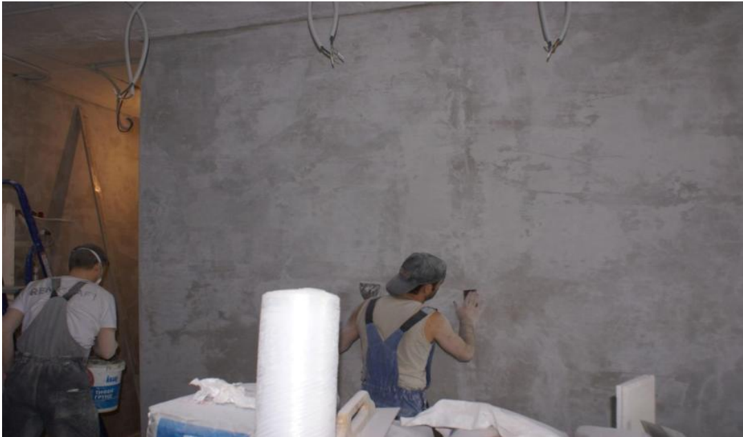
Шпатлевание внутренних стен, 04.04.2018
