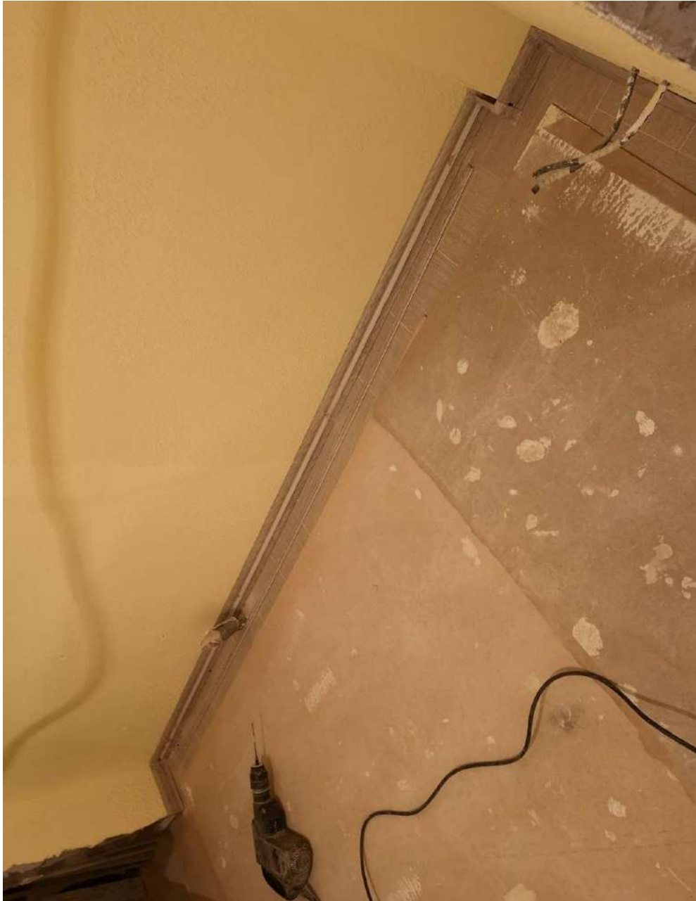
Монтаж плинтусов в цоколе.
