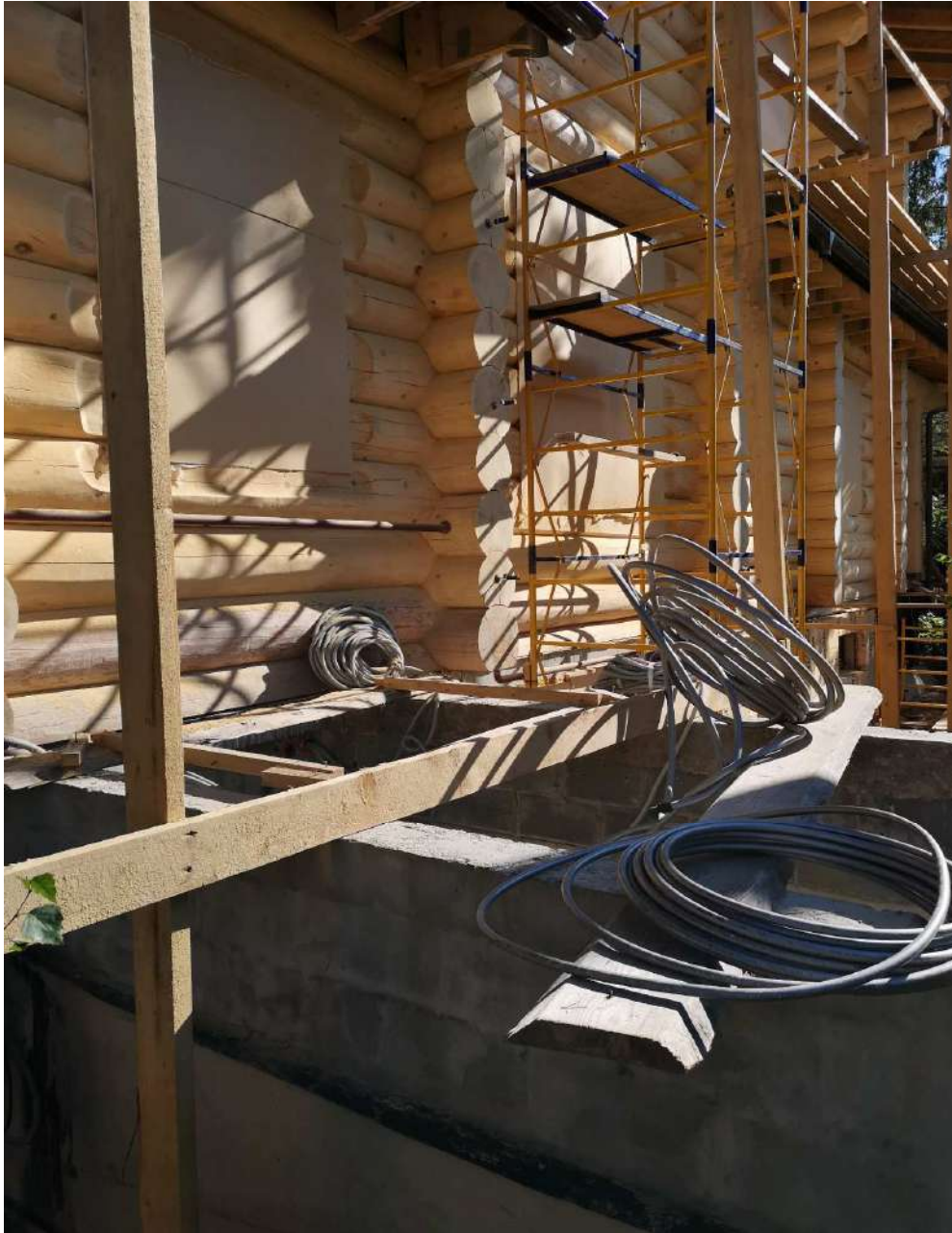
Шлифовка наружных стен.
