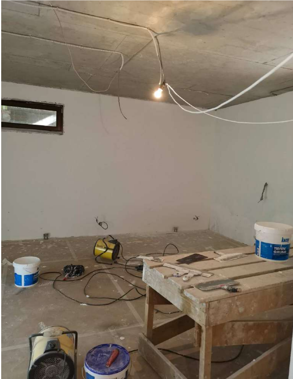
Окраска стен цоколя.
