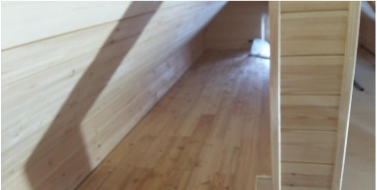
Обшивка доской полов и стен чердака
