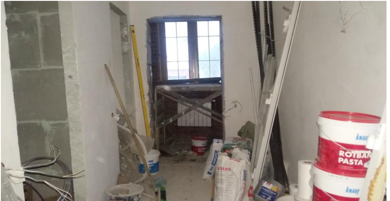
Внутренняя отделка стен
