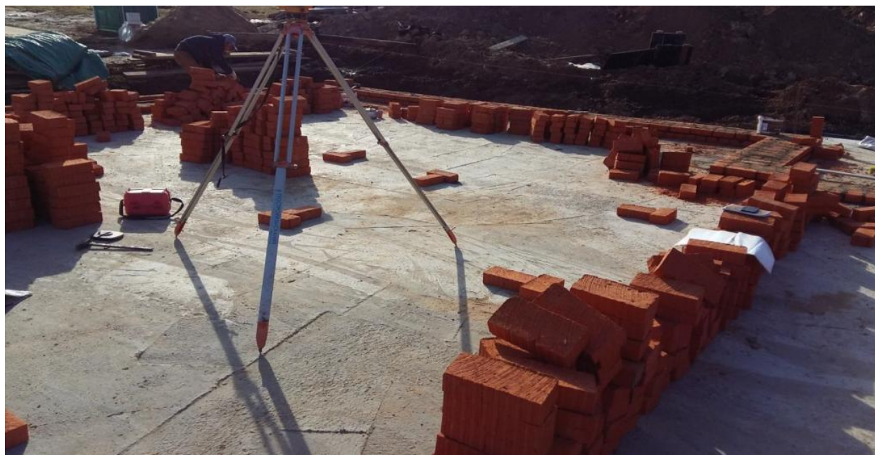
Кирпичная кладка цоколя.
