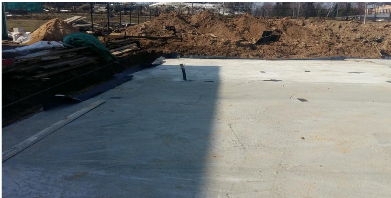
Бетонирование фундаментной плиты.
