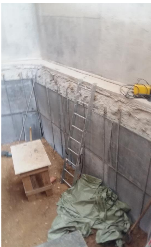
Устройство подпорной стенки
