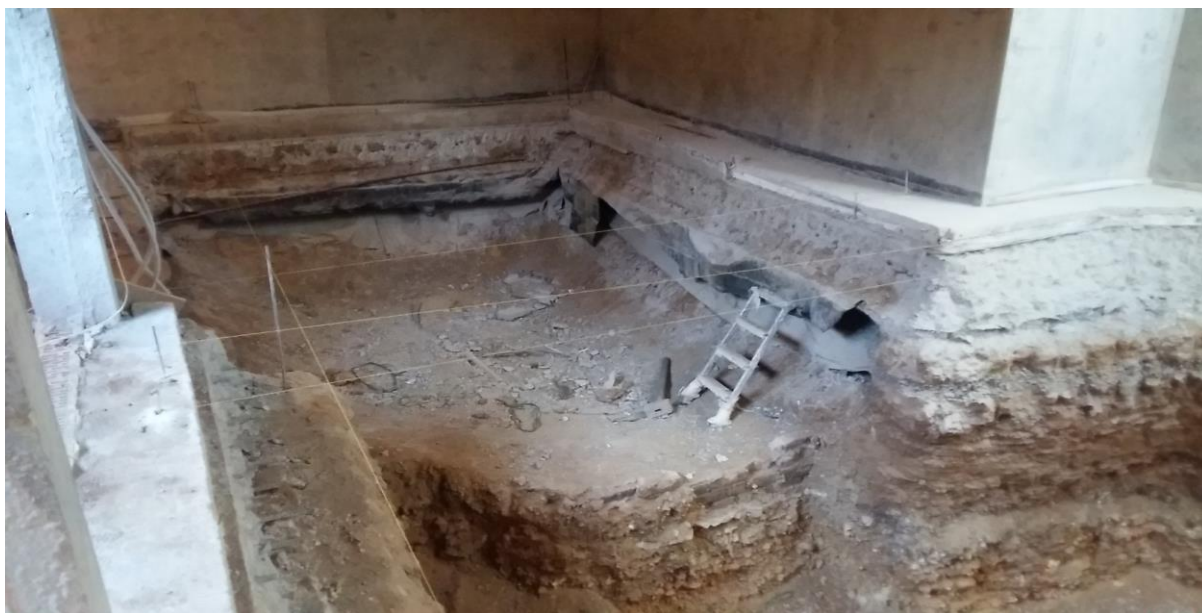
Выемка грунта чаши бассейна
