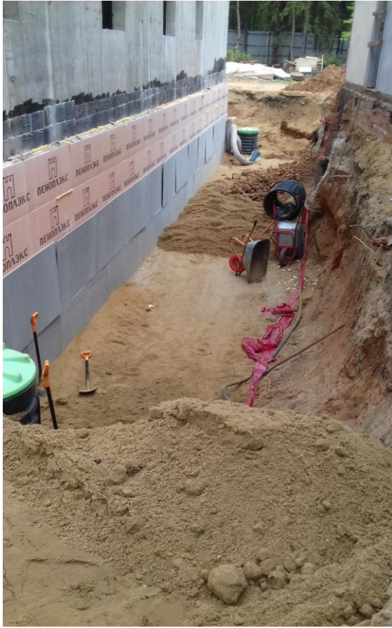
Укладка сигнальной ленты вдоль трассы электрокабеля.
