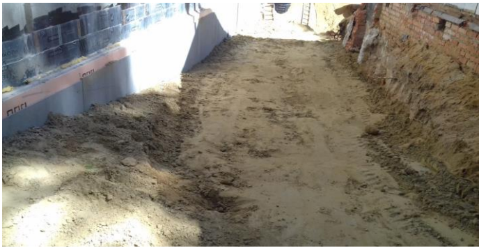
Засыпка с трамбовкой.
