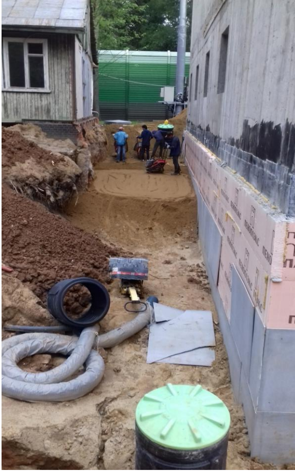
Засыпка с послойной трамбовкой.
