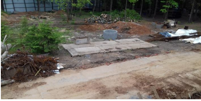
Демонтаж арматурного цеха.
