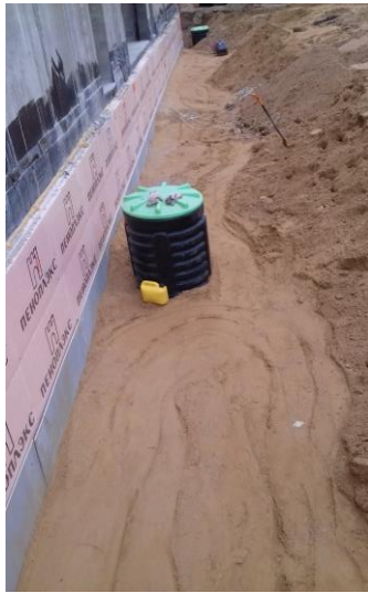
Засыпка котлована песком с послойной трамбовкой.
