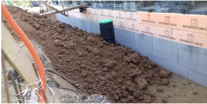
Засыпка котлована песком с послойной трамбовкой.
