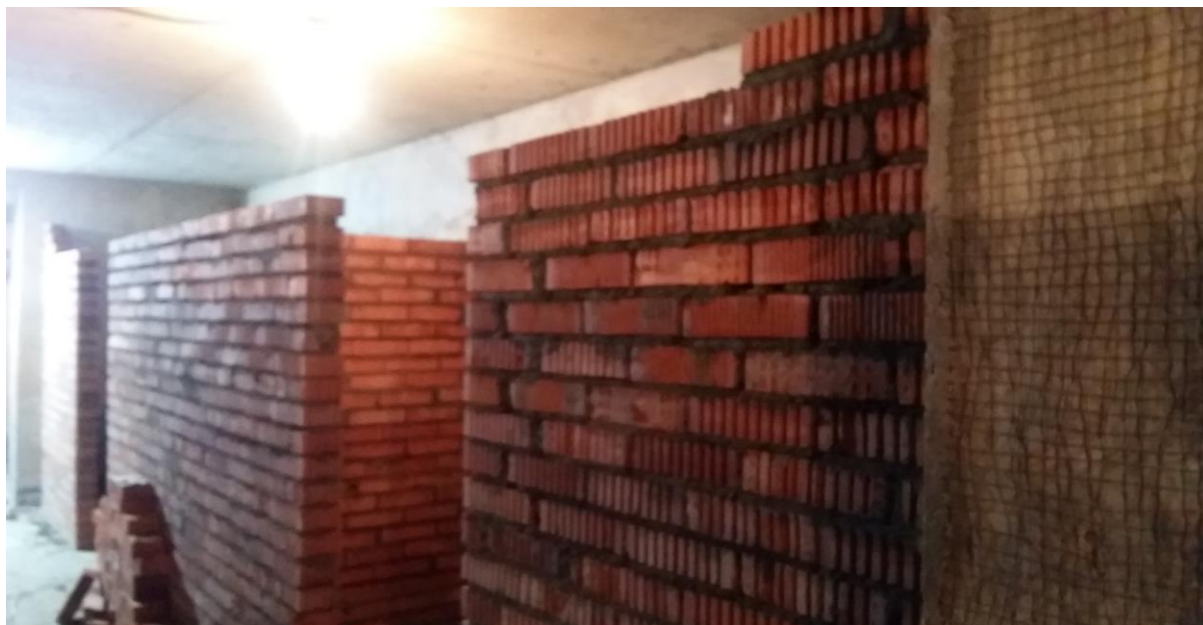
Кирпичная кладка перегородок
