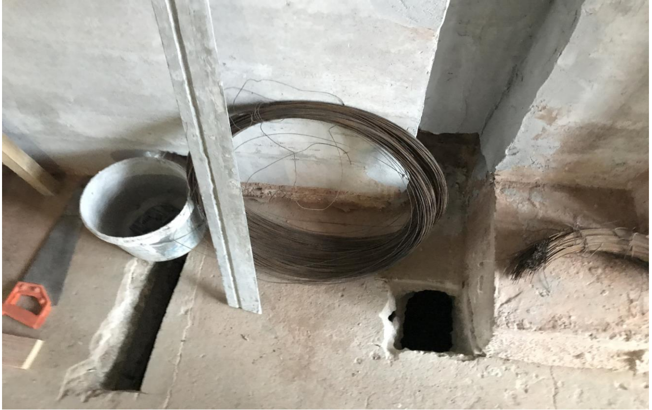
Устройство технологических отверстий для инженерных разводок.
