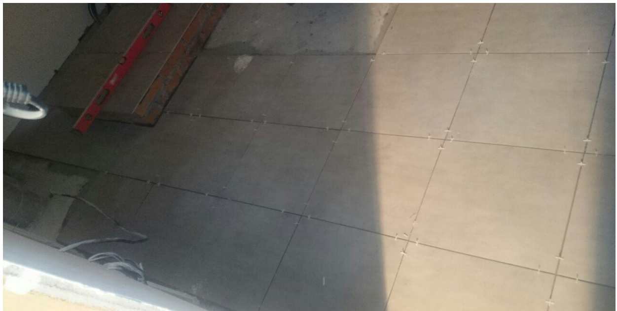
Плиточные работы в помещении котельной
