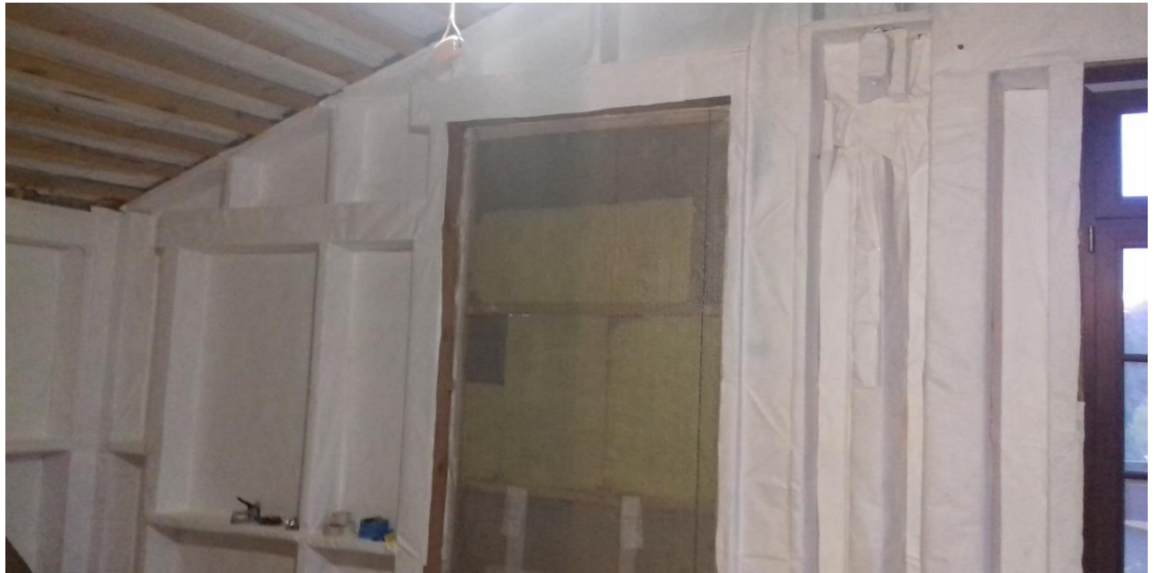
Обшивка наружных стен 2-го этажа пароизоляцией.
